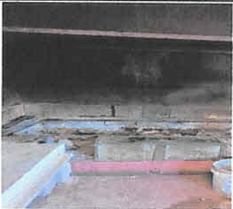
Sustitución de 1 parrillas de metal de 0.75x 0.80 mts
