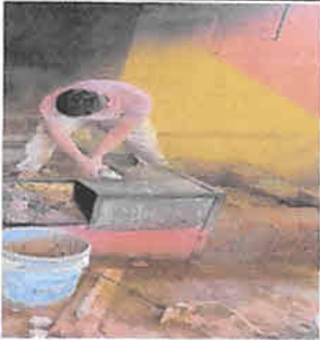
Mantenimiento de 1 polleton en cocina de 3.10 X 1.25 mt, con angular de 1 1/2" por 3/16" de grosor.
