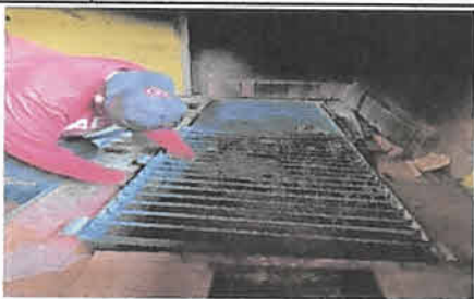
Sustitución de 1 parillas de metal de 0.75x 1.75 mts
