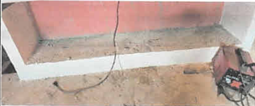
Sustitución de mesa de trabajo en cocina fundida de concreto de 3.75 x 0.40 mts mas base
