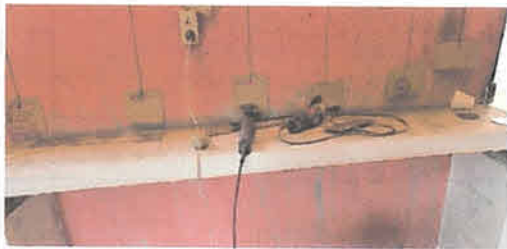
Sustitución de mesa de trabajo en cocina fundida de concreto de 2.75 m x 0.60 m
