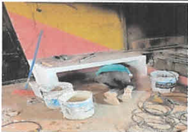
Sustitución de mesa de trabajo en cocina fundida de concreto de 3.75 x 0.60 de ancho mas bases
