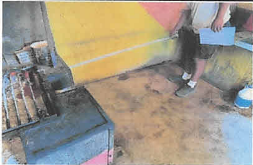
Sustitución de 1 parrillas de metal de 0.75x 0.80 mts
