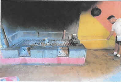
Mantenimiento de 1 polleton en cocina de 3.10 X 1.25 mt, con angular de 1 1/2" por 3/16" de grosor.
