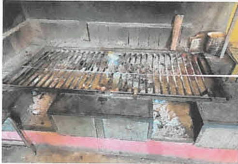
Sustitución de 1 parrillas de metal de 0.75x 1.75 mts
