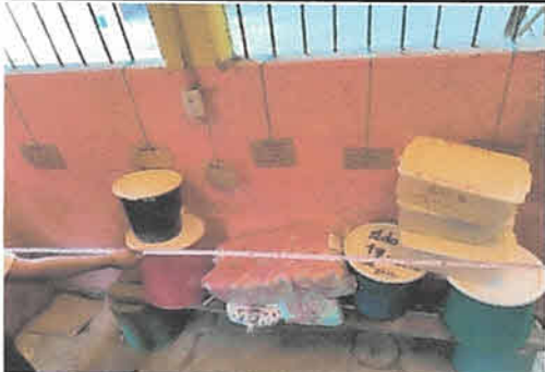
Sustitución de mesa de trabajo en cocina fundida de concreto de 3.75 x 0.40 mts mas base
