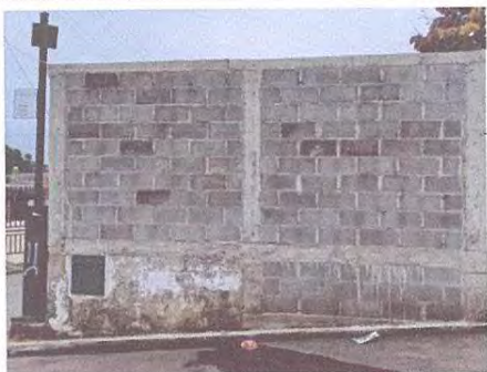
Repello y cernido de paredes en cocina por fuera
