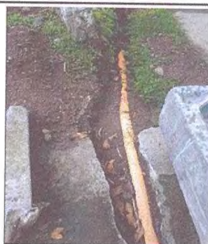
Reparación de red de drenaje 35 M
