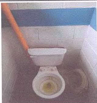
Sustitución de tazas sanitarias
