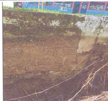
Reparación de muro de contención existente con columnas de 20X30 de 4 metros.
