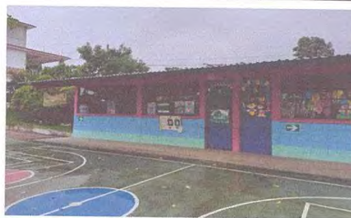
Mantenimiento correctivo de canal y bajada de agua pluvial
