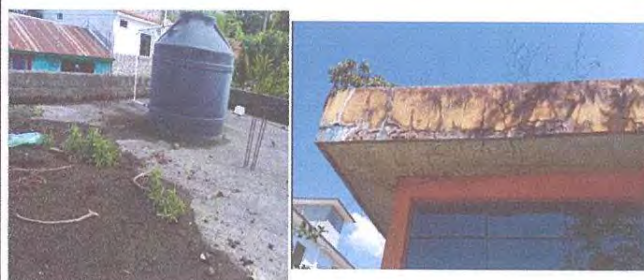
Reparación y mantenimiento de rotoplas y bomba
