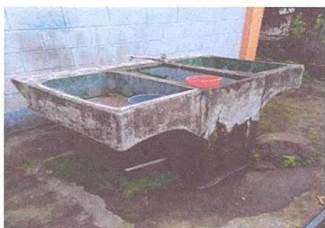
Sustitución de pila de cemento.
