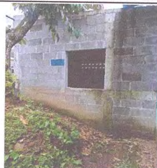
Mantenimiento correctivo de ventana PVC con balcón 1M X 1M
