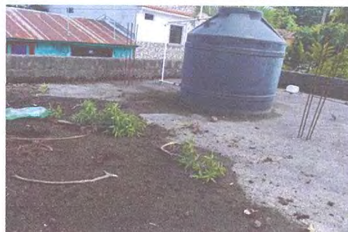
Reparación de loza de concreto con impermeabilización en baños.
