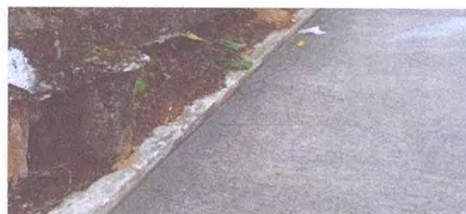
Reparación de muro perimetral existente con blocks
