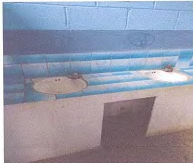
Reparación de lavamanos en sanitario.
