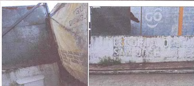
Mejoramiento de pared de baño.
