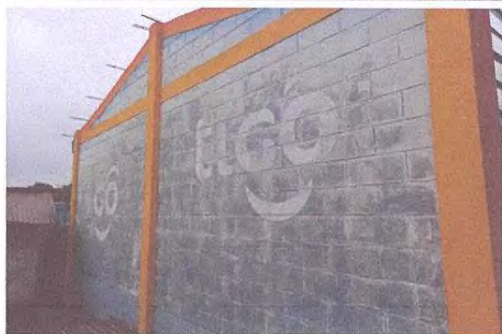
Suministro y aplicación de pintura exterior pantone azul y celeste
