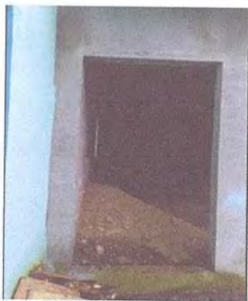
Mejoramiento correctivo de puerta en cocina
