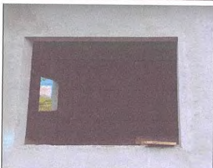
Mantenimiento correctivo de ventana 1.35M X 1.35M
