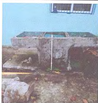
Sustitución de pila de cemento por pila plastica
