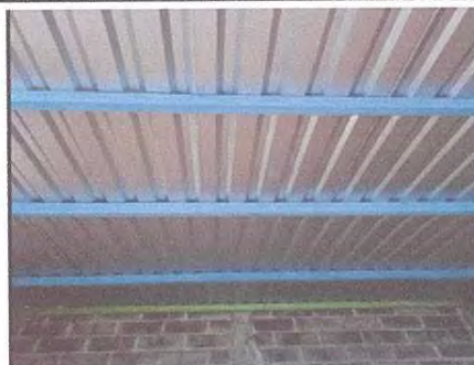
Sustitución de lamina troquelada por lamina opalina de 10 pies en modulo 4
