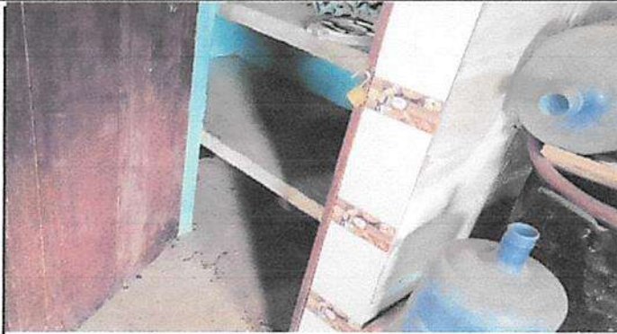
Sustitucion de azulejo en cocina
