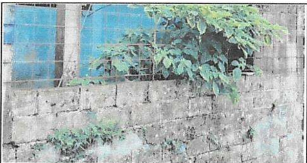
Repello en muros de cocina
