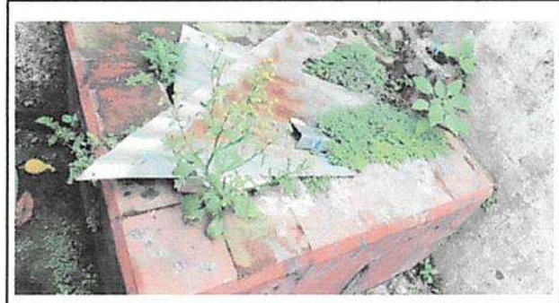
Sustitucion de estufa en cocina con ladrillo y chimenea
