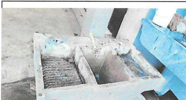
Sustitucion de pilas
