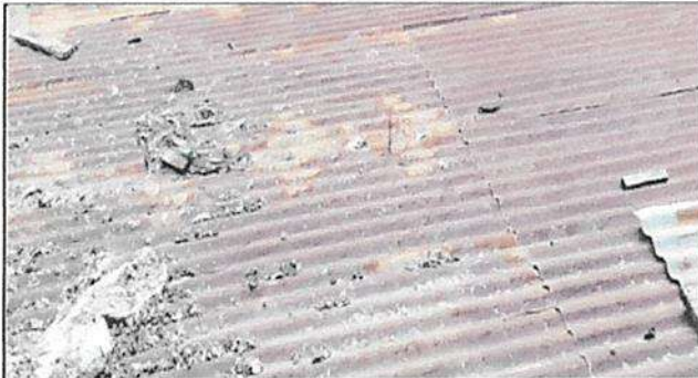
Sustitución de lámina por lamina troquelada calibre 26 en cocina
