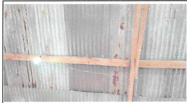
Sustitución de estructura de soporte madera por metal en modulo 1
