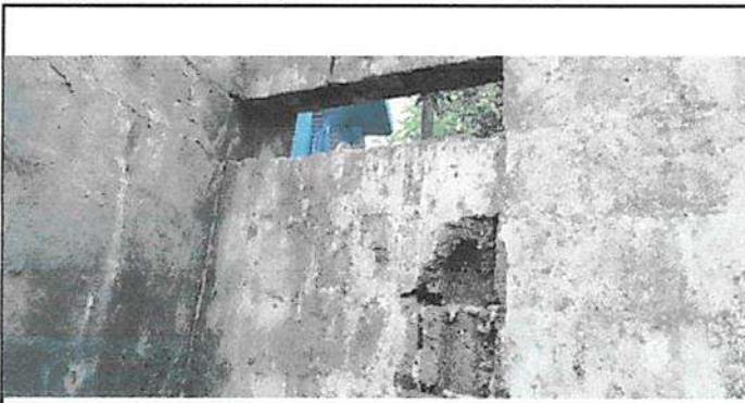
Suministro y aplicación de pintura en cocina
