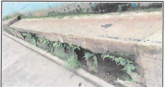
Reparacion de banqueta de concreto
