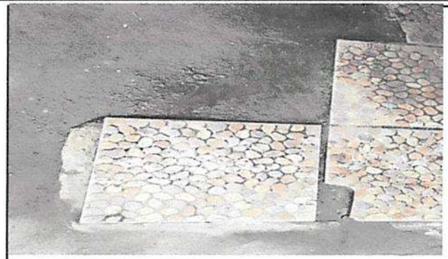
Sustitucion de piso de ceramico en cocina
