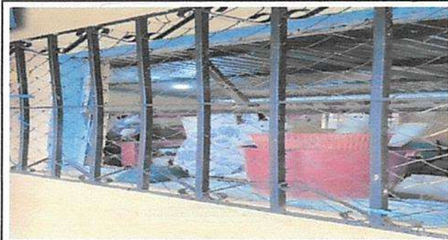
Sustitución de ventanas tipo UPV-C
