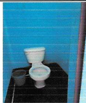
Sustitución de inodoros en modulos de sanitarios
