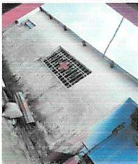
Suministro e intalación de lámina troquelada cal 26 en modulo A
