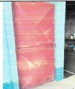
Mantenimiento de puertas en modulos A,B,C,D,E con pintura r15 de aceite
