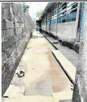
Sustitución de tubería de agua potable en pilas
