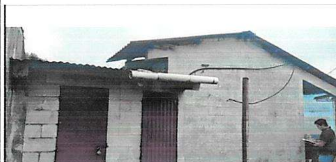
Sustitución de puertas metalicas en Modulo de sanitarios
