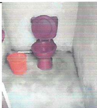
Sustitución de piso a antidezlisante en Modulo de sanitarios
