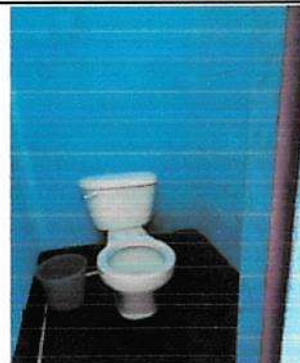
Instalacion de piso ceramico en muros de modulo de sanitarios altura 1.4 de alto
