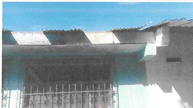
Suministro e Instalación de Lámina Cal. 26 en modulo 2
