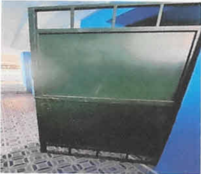
Mantenimiento a estructura de puerta (lijado, cepillado, sujeciones, aplicación de pintura) en S.S. de niños 4m2
