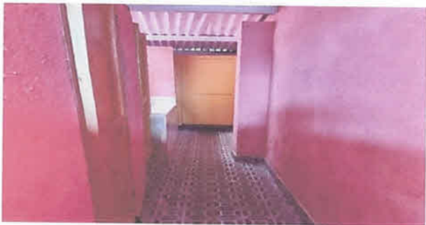
Pintura en muro S.S. de niñas 35 mt2.
