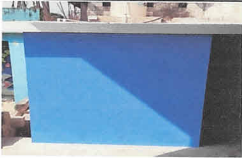
Losa electropanel recubierta de mortero 5 mt2
