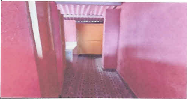
Sustitucion de piso por piso cerámico en S.S. de niñas 10mt2
