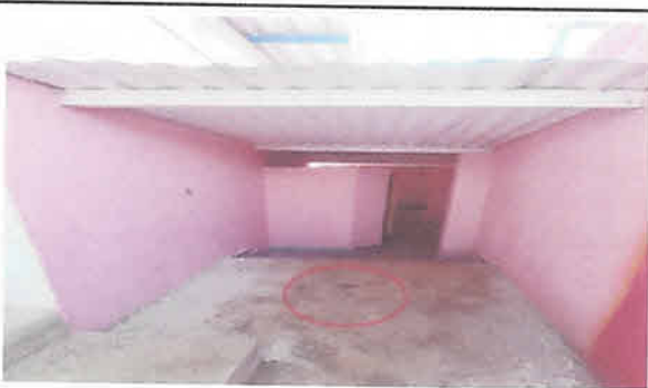
Sustitución de reposaderas 3"x3" para servicios sanitarios 2 mt2
