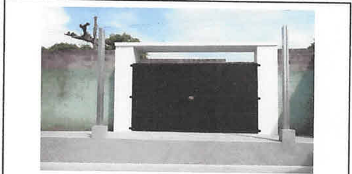
Losa electropanel recubierta de mortero en porton
