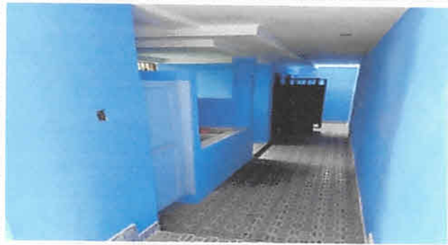
Reparacion de losas interiores con repello en S.S de niños 20 mt2
