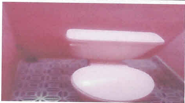
Sustitucion de inodoro elongado en S.S. de niñas unidad
