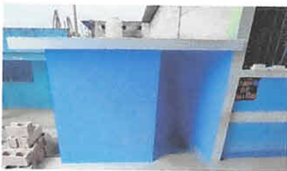
Mejoramiento de modulo de servicio sanitario para maestros unidad
