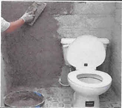
Reparacion de muros interiores con repello en S.S. de niños 100m2
