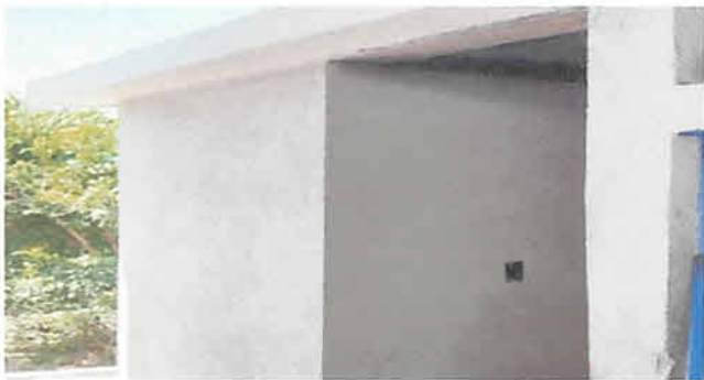
Mejoramiento de modulo de servicio sanitario para maestros unidad
