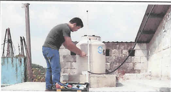
Sustitucion de depósito de agua de 450 litros más accesorios Unidad
