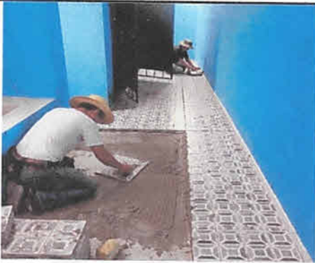
Sustitucion de piso cerámico en S.S. de niños 20 m2.
