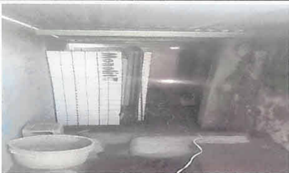
Reparación de muros interiores con repello en S.S. de niñas 35 m2
