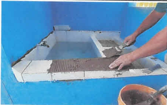
Mantenimiento correctivo de muro con azulejo en S.S. de niños pila y mingitorio 12 m2
