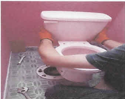
Sustitucion de inodoro elongado en S.S. de niñas unidad
