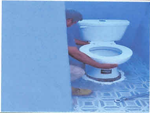
Sustitucion inodoro elengado en S.S. de niños unidad
