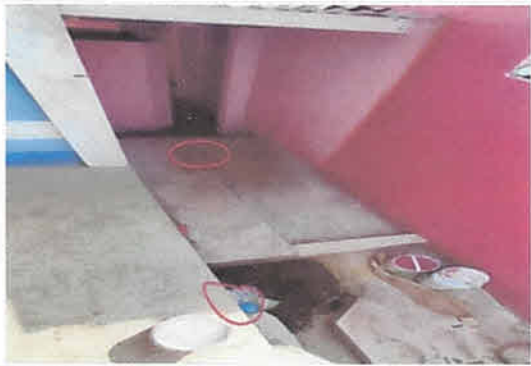
Sustitución de reposaderas 3"x3" para servicios sanitarios 2 mt2
