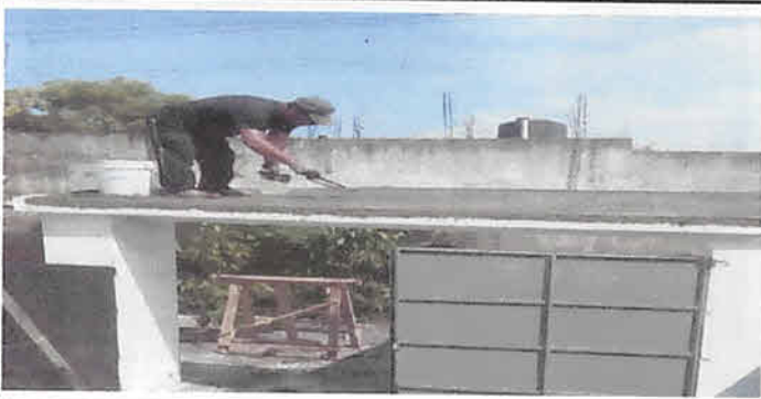
Losa electropanel recubierta de mortero en porton
