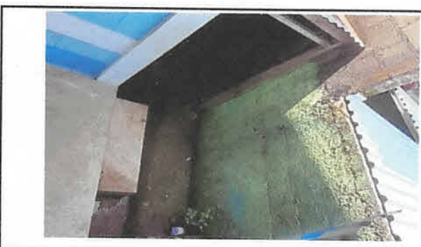
Sustitución de reposaderas 3"x3" para servicios sanitarios 2 m2
