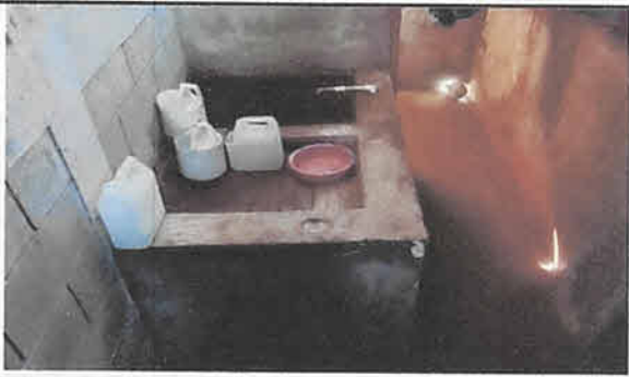
Mantenimiento correctivo de muro con azulejo en S.S. de niñas en pila 8m2
