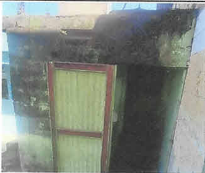
Sustitución de cubierta de lámina por lamina troquelada calibre 26 en S. S. de niños
