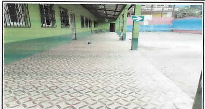
Sustitución de piso de concreto a piso cerámico de 33 x 33 cm color pavimento Nilo Marrón, corredor modulo 2.
