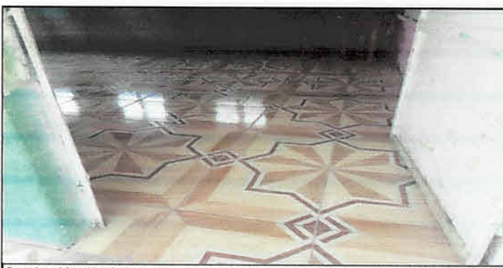
Sustitución de piso de concreto a piso cerámico de 43 x 43 cm color Ceiba Caoba, Aulas módulo 2.
