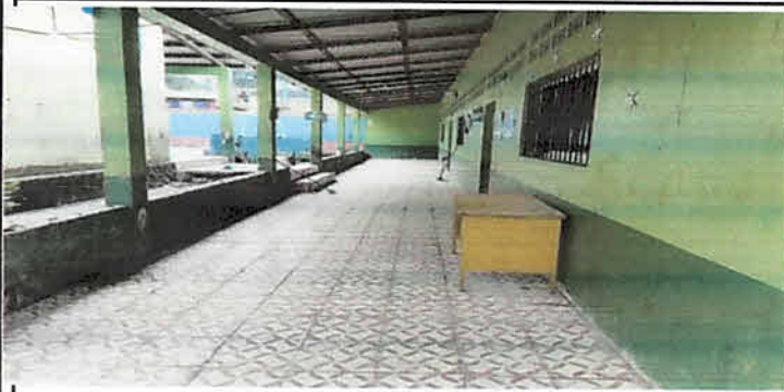
Sustitución de piso de concreto a piso cerámico de 33 x 33 cm color pavimento Nilo Marrón, corredor modulo 1.
