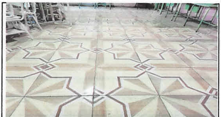
Sustitución de piso de concreto a piso cerámico de 43 x 43 cm color Ceiba Caoba, Aulas módulo 1.
