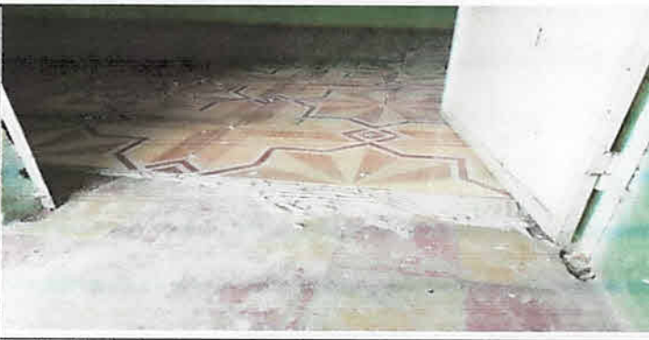
Sustitución de piso de concreto a piso cerámico de 43 cm x 43 cm, color Ceiba Caoba. Aulas Módulo 2.
