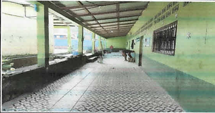
Sustitución de piso de concreto a piso cerámico de 33cm x 33 cm, color Pavimento Nilo Marron, corredor modulo 1.
