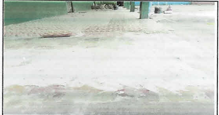
Sustitución de piso de concreto a piso cerámico de 33cm x 33 cm, color Pavimento Nilo Marron, corredor modulo 2.
