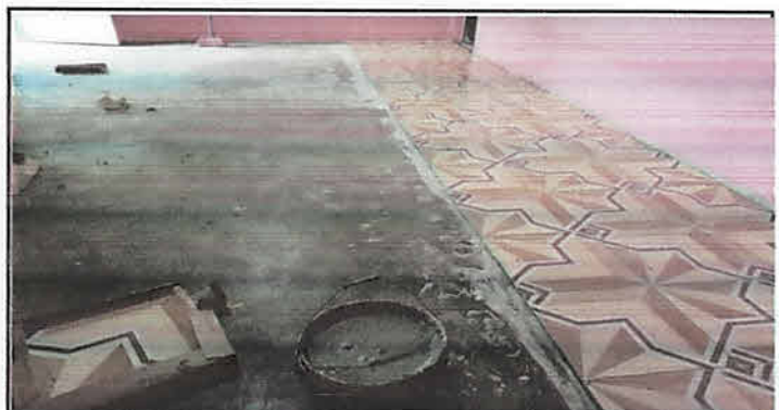
Sustitución de piso de concreto a piso cerámico de 43 cm x 43 cm, color Ceiba Caoba. Aulas Módulo 1.
