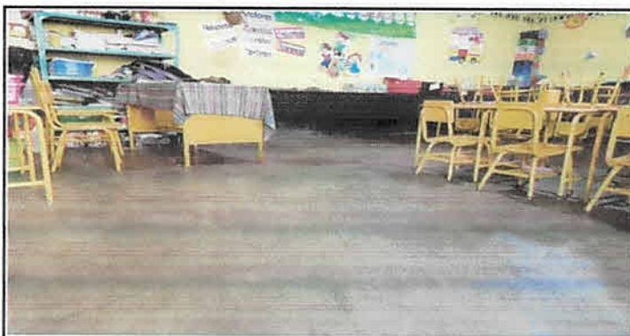
Sustitución de piso de concreto a piso cerámico de 43 cm x 43 cm color Ceiba Caoba. Aulas Modulo 1.
