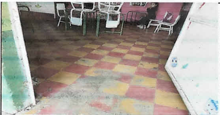
Sustitución de piso de concreto a piso cerámico de 43 cm x 43 cm, color Ceiba Coaoba, Aulas modulo 2.
