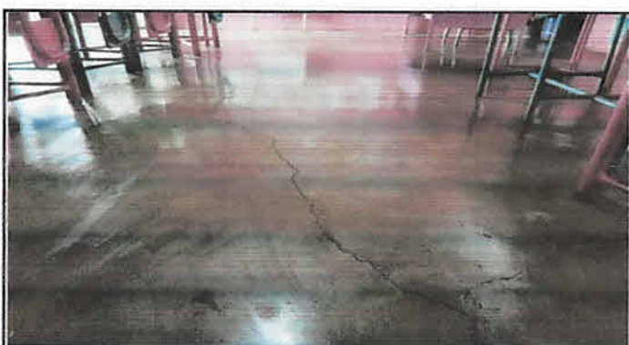
Sustitución de piso de concreto a piso cerámico de 43 cm x 43 cm color Ceiba Caoba. Aulas Modulo 1.
