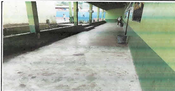
Sustitución de piso de concreto a piso cerámico de 33 cm x 33 xcm color Pavimento Nilo Marron, corredor modulo 1.
