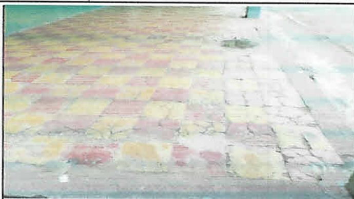
Sustitución de piso de concreto a piso cerámico de 33 cm x 33 xcm color Pavimento Nilo Marron, corredor modulo 2.
