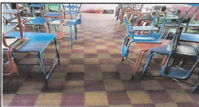
Sustitución de piso de concreto a piso cerámico de 43 cm x 43 cm, color Ceiba Coaoba, Aulas modulo 2.
