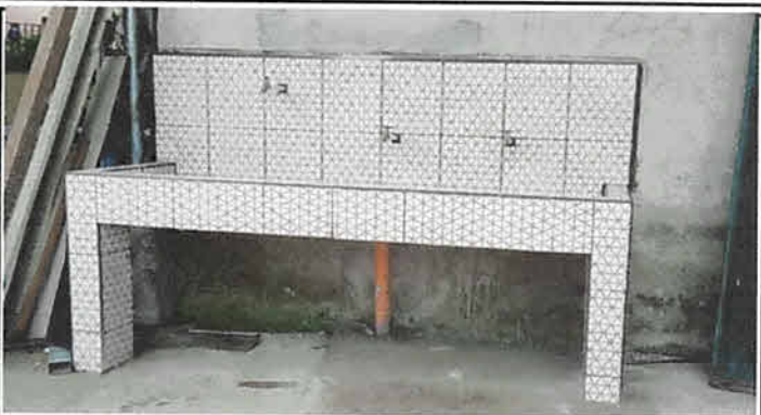
Foto 2: Sustitución de lavamanos en ingreso trasero + instalación hidráulica
