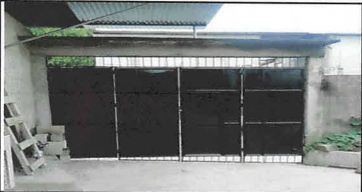
Foto 3: Mantenimiento de porton metálico, ingreso no. 2 (lijado, pintado, y cambio de perfiles dañados)
