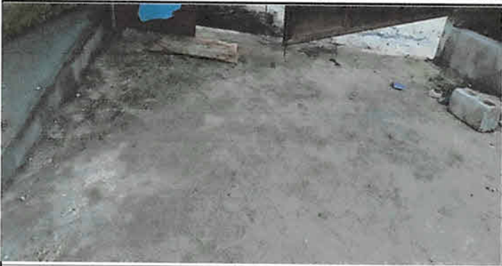
Foto1: Reparación de rampa de ingreso no. 2 de escuela
