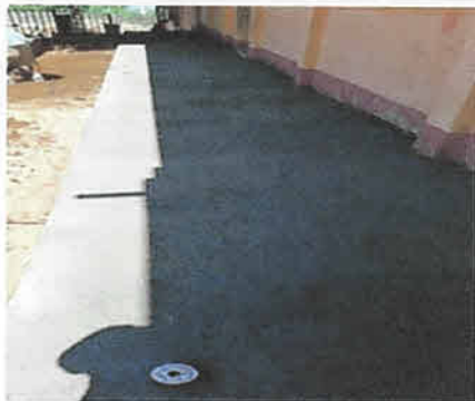
Foto 10: Reparación de banquetas de concreto
