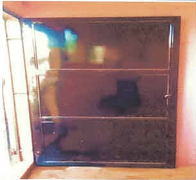
Foto 17: Mantenimiento a estructura de puerta (lijado, cambio de perfil dañado, cepillado y cambio de chapa)
