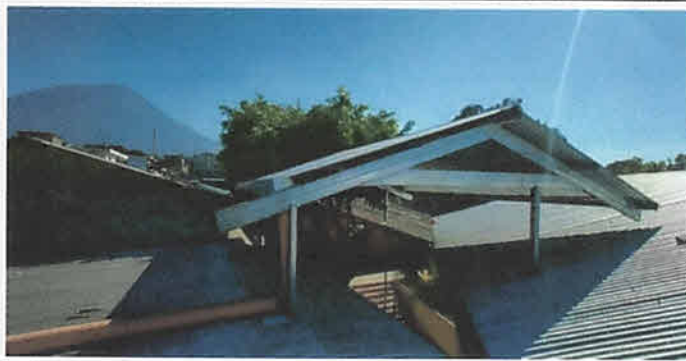
Foto 8: Sustitución de lámina por lámina troquelada calibre 26 + drenaje pluvial
