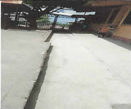
Foto 11: Reparación de cuneta de concreto
