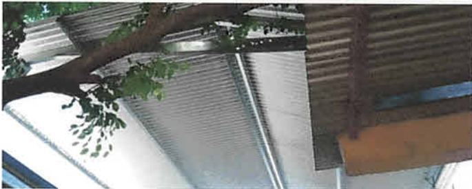
Foto 9: Sustitución de estructura de soporte
