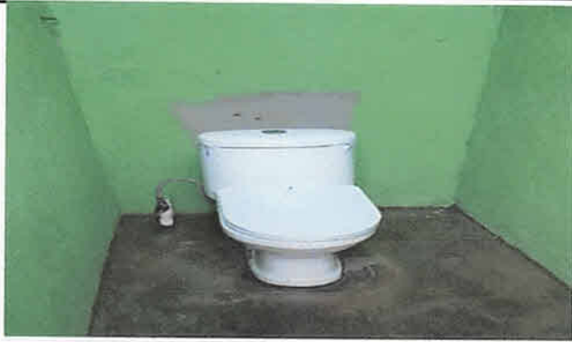
Foto 14: Sustitución de inodoros elongados para niños
