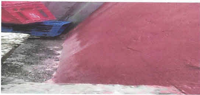
Foto 15: Impermeabilización de pared
