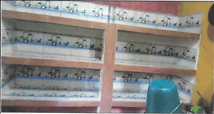
Foto 7: Sustitución de repisa de madera por concreto, en cocina
