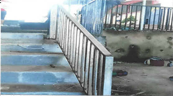
Foto 13: Sustitución de baranda de metal en gradas
