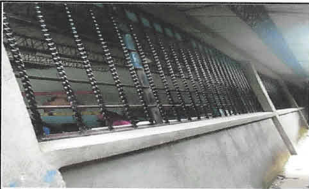
Foto 16: Reparación de balcones en aulas 5b, 4b 3ro + retiro de vidrios de 5 mm+ aplicación de anticorrosivo
