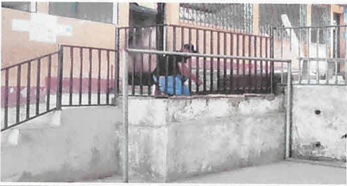
Foto 13: Sustitución de baranda de metal en gradas
