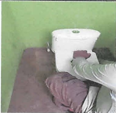
Foto 14: Sustitución de inodoros elongados para niños
