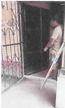
Foto 6: Sustitución de puerta de metal en cocina
