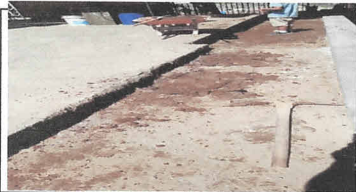
Foto 11: Reparación de cuneta de concreto
