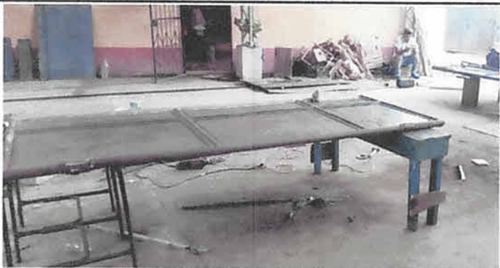
Foto 3: Mantenimiento de porton metálico, ingreso no. 2 (lijado, pintado, y cambio de perfiles dañados)
