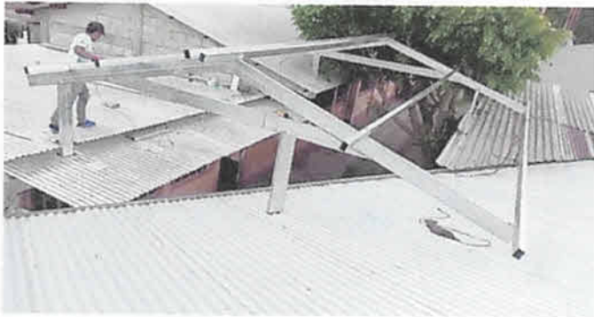
Foto 8: Sustrucción de lámina por lámina troquelada calibre 26 + drenaje pluvial
