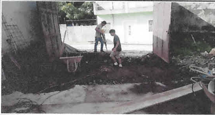
Foto1: Reparación de rampa de ingreso no. 2 de escuela
