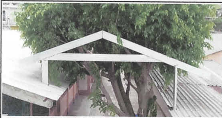
Foto 9: Sustrucción de estructura de soporte
