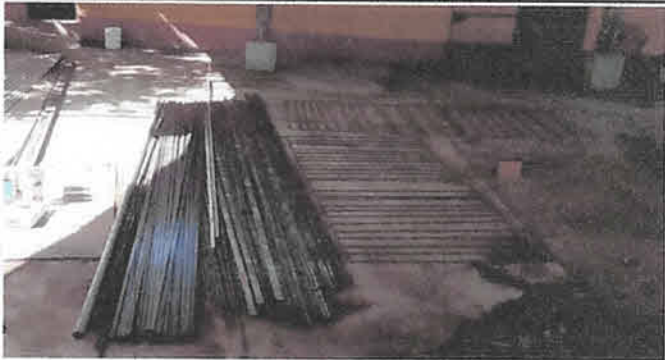
Foto 16: Reparación de balcones en aulas 5b, 4b 3ro + retiro de vidrios de 5 mm+ aplicación de anticorrosivo
