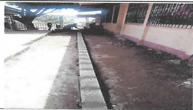
Foto 10: Reparación de banquetas de concreto
