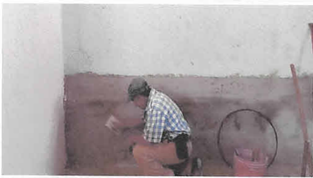
Foto 15: Impermeabilización de pared
