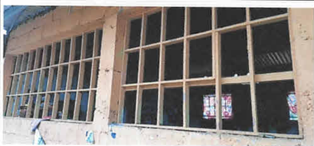
foto 5: Sustitución de balcon de madera por metal
