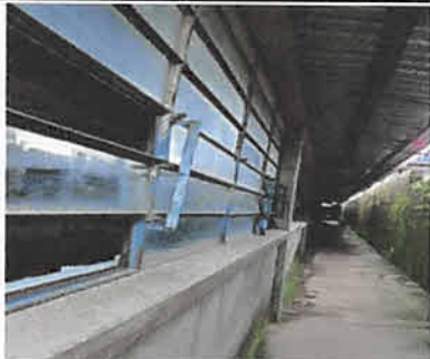
foto no .16 Reparación de balcones en aulas 5b, 4b 3ro + retiro de vidrios de 5 mm+ aplicación de anticorrosivo
