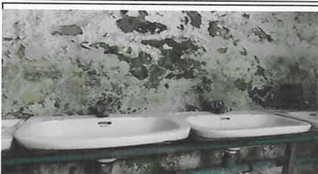
foto 2: sustitucion de lavamanos en ingreso trasero + instalacion hidraulica
