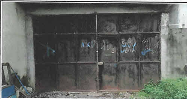
foto 3: Mantenimiento de portón metálico, ingreso no. 2 (lijado, pintado, y cambio de perfiles dañados)
