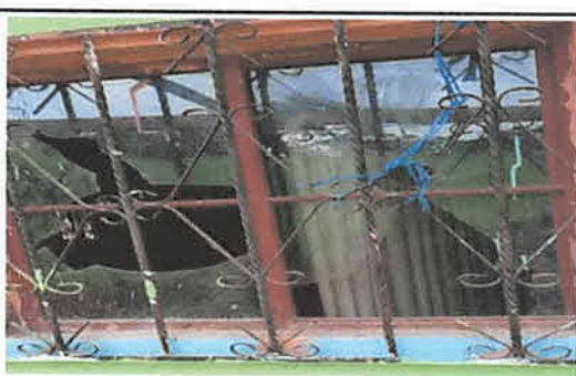
foto 4. Sustitución de estructura de metal de ventana de 2 * 0.60 m , en cocina + tallado en marco de ventana
