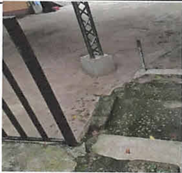
foto no. 13 Sustitución de baranda de metal en gradas
