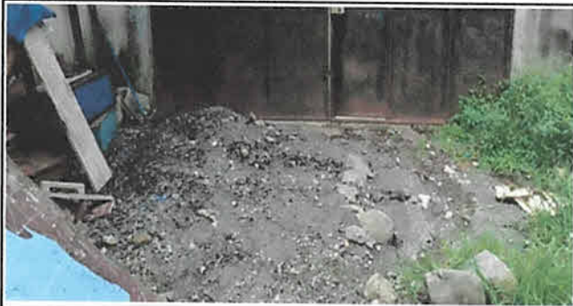
Reparación de rampa de ingreso no. 2 de escuela
