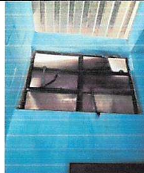
Sustitución de ventanas en Modulo de sanitarios
