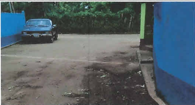
Sustitución de tubería PVC de 3" línea principal, drenaje de la cocina.
