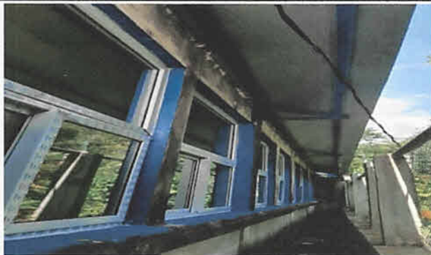
Mantenimiento correctivo de estructura y soporte de metal en ventanas, 15 m
