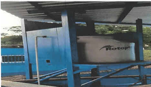
Instalación de depósito de agua de 1,100 lts para la cocina con estructura de metal.
