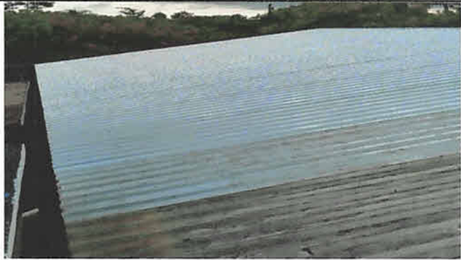
Sustitución de lámina por lámina troquelada calibre 26, en dos aulas. 116 m2
