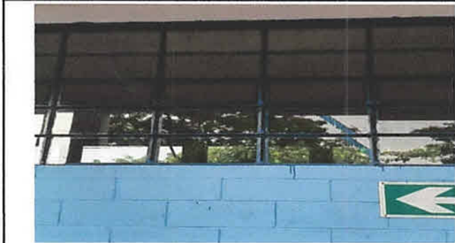
Mantenimiento a estructura de metal y suministro e instalación de vidrios de 5 mm en ventanas de diferentes medidas en dos aulas, 6 unidades.
