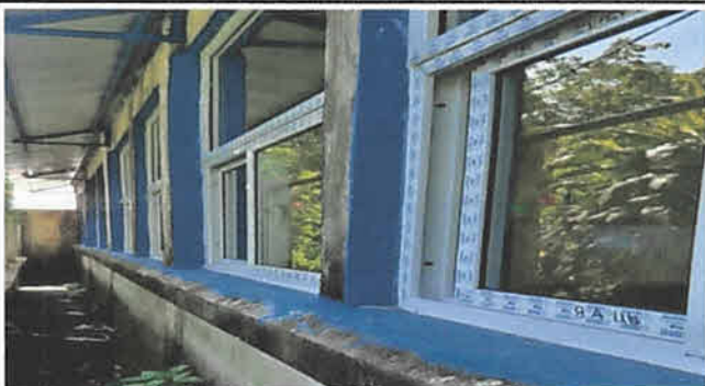
Sustitución de ventanas de metal a ventanas de PVC, parte inferior corrediza con vidrios de 5 mm de diferentes medidas, en dos aulas, 8 unidades.
