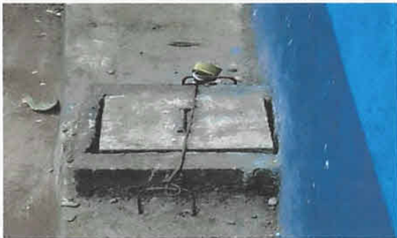
Mantenimiento a cajas de registro drenaje de la cocina.
