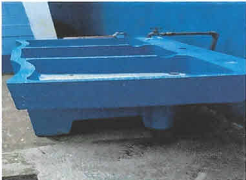
Sustitución e instalación de pila de cemento de dos lavaderos.
