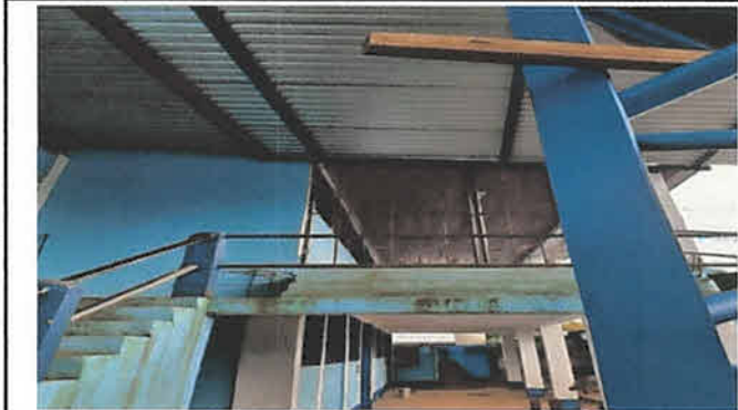
Sustitución de lámina calibre 26, con soporte de estructura de metal para darle mantenimiento al módulo de gradas, 18 m2.
