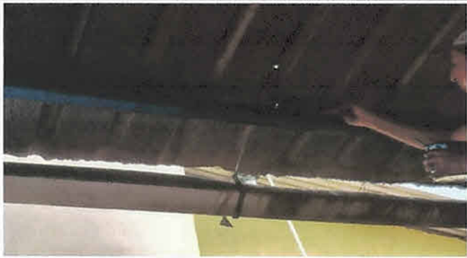
Mantenimiento a estructura de soporte de metal en dos aulas, lijado y pintura anticorrosiva. 148 m2
