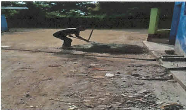
Sustitución de tubería PVC de 3" línea principal , drenaje de la cocina.
