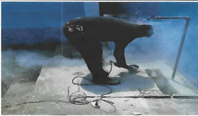
Sustitución e instalación de pila de cemento de dos lavaderos.
