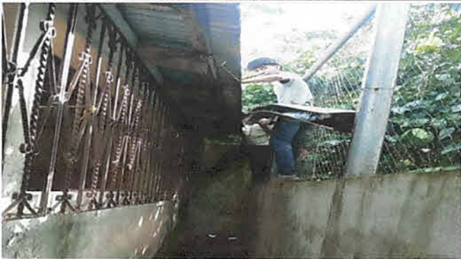
Sustitución de canal de metal, alto caudal calibre 26 con bajada de aguas pluviales de PVC 3" con abrazadera, 35 m
