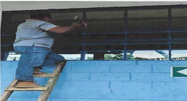
Mantenimiento a estructura de metal y suministro e instalación de vidrios de 5 mm en ventanas de diferentes medidas en dos aulas, 6 unidades.
