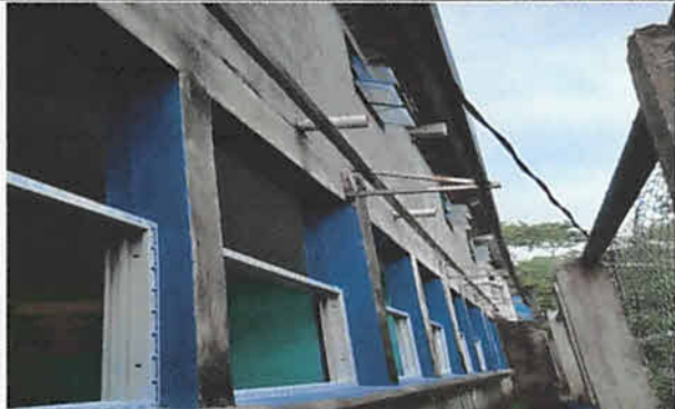
Mantenimiento correctivo de estructura y soporte de metal en ventanas, 15 m
