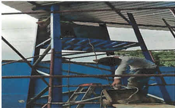
Instalación de depósito de agua de 1,100 lts para la cocina con estructura de metal.
