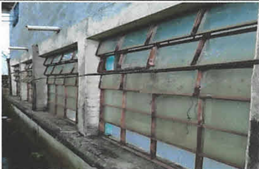
Sustitución de ventanas de metal a ventanas de PVC, parte inferior corrediza con vidrios de 5 mm de diferentes medidas, en dos aulas, 8 unidades
