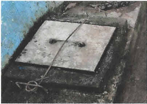
Mantenimiento a cajas de registro drenaje de la cocina
