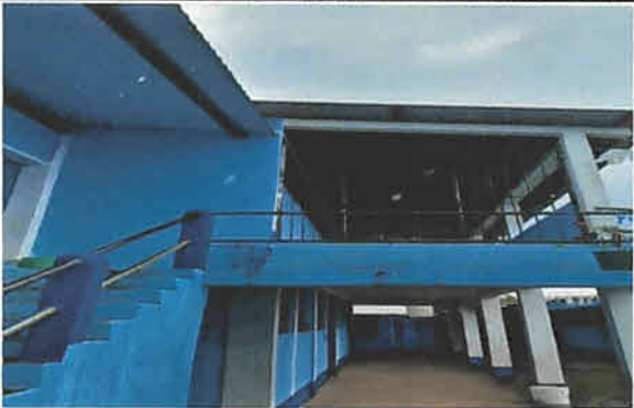
Sustitución de lámina calibre 26, con soporte de estructura de metal para darle mantenimiento al módulo de gradas, 18 m2
