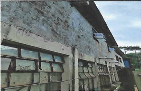
Mantenimiento correctivo de estructura y soporte de metal en ventanas, 15 m.
