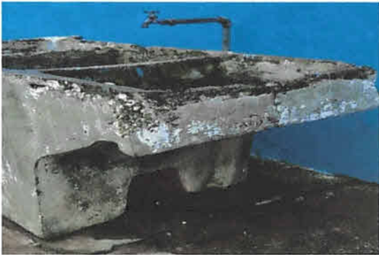
Sustitución e instalación pila de cemento dos lavaderos.
