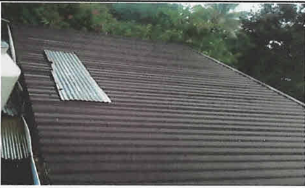
Sustitución de lámina por lámina troquelada calibre 26, en dos aulas. 116 m2.
