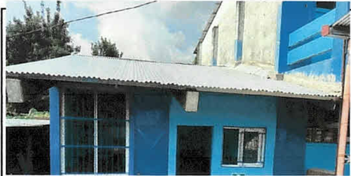
Foto 4: Suministro e instalación de lámina acanalada calibre 26 en cocina 50 mts.2
