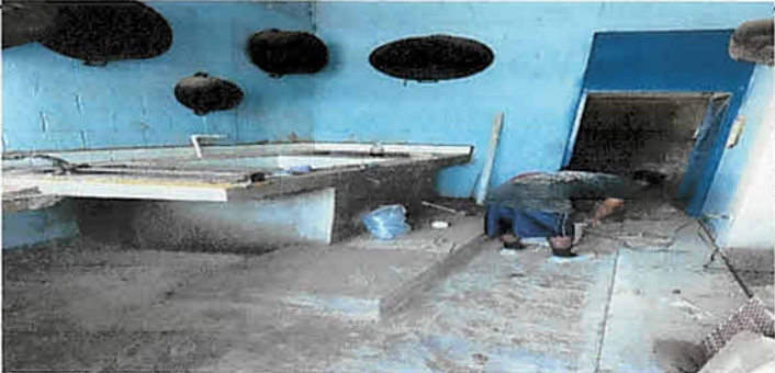
Foto 3: Suministro e instalación de piso cerámico en cocina 45 mts.2
