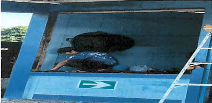
Foto 5: Sustrucción de balcón en cocina con varilla de hierro entorchado soldado con pines 6 mts.2
