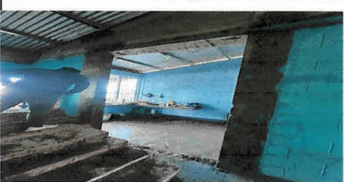
Foto 2: Mantenimiento correctivo de muro con columna de 0.15*0.15 y solera en cocina 6 mts.2
