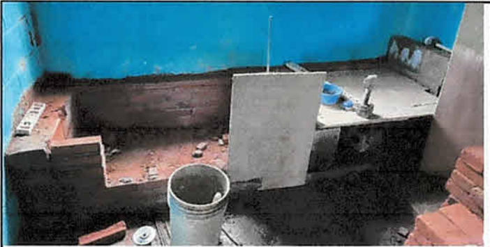
Foto 6: Sustrucción de estufa con ladrillo y chimenea de metal en cocina 7 mts.2
