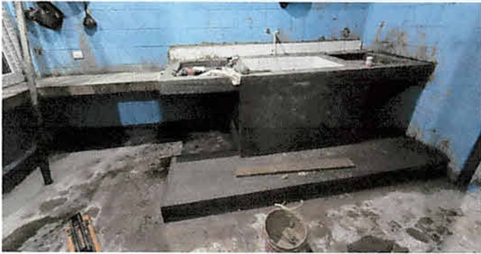
Foto1: Sustrucción de pila de cemento de dos lavaderos en cocina de 5mts.2
