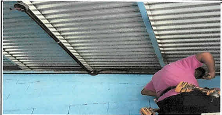
Foto7: Suministro e instalación de artefactos de iluminación (6 focos, 2 tomacorrientesy 1 flipón) en cocina
