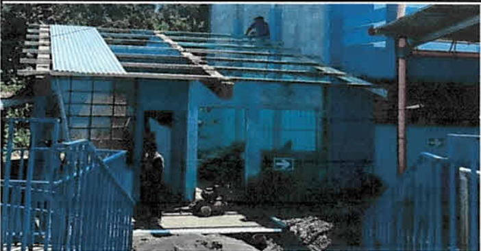
Foto 4: Suministro e instalación de lámina acanalada calibre 26 en cocina 50 mts.2
