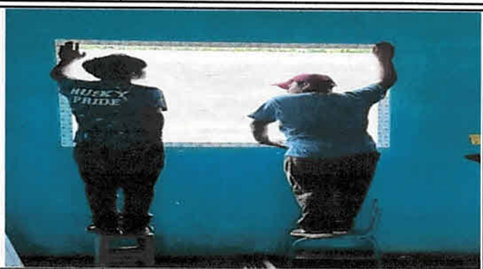
Foto 8: Suministro e instalación de ventana en cocina 8 mts.2
