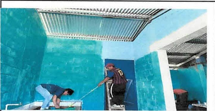
Foto 9: Suministro y aplicación de pintura látex lavable en cocina 100 mts.2
