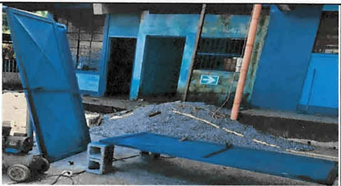
foto 10: Mantenimiento de puertas de metal en cocina 2 puertas
