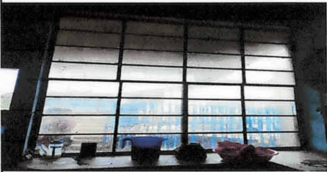
Foto 8: Suministro e instalación de ventana en cocina 8 mts.2
