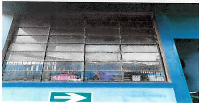
Foto 5: Sustitución de balcón en cocina con varilla de hierro entorchado soldado con pines 6 mts.2
