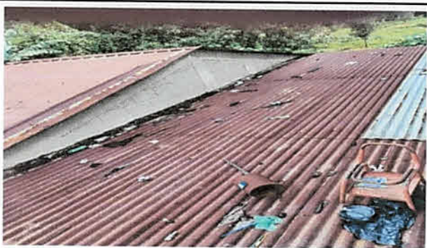
Foto 4: Suministro e instalación de lámina acanalada calibre 26 en cocina 50 mts.2
