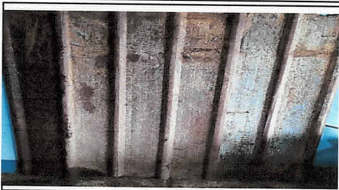
Foto 2: Mantenimiento correctivo de muro con columna de 0,15*0.15 y solera en cocina de 6mts.2
