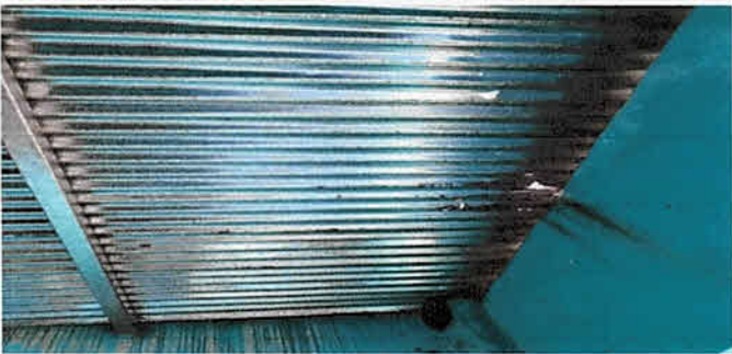
Foto 9: Suministro y aplicación de pintura interior látex lavable en cocina 100 mts.2
