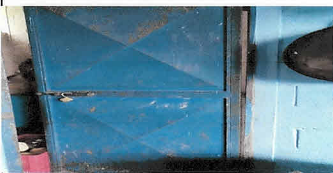
Foto 10: Mantenimiento de puertas de metal en cocina 2 puertas
