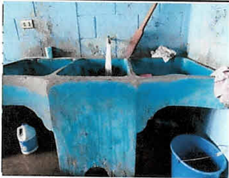
Foto 1. Sustitución de pila de cemento de dos lavaderos en cocina de 5*5mts.2
