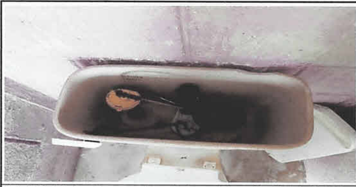
Foto 5: Sustitucion de accesorios en baños + sistema idraulico de depósito de agua
