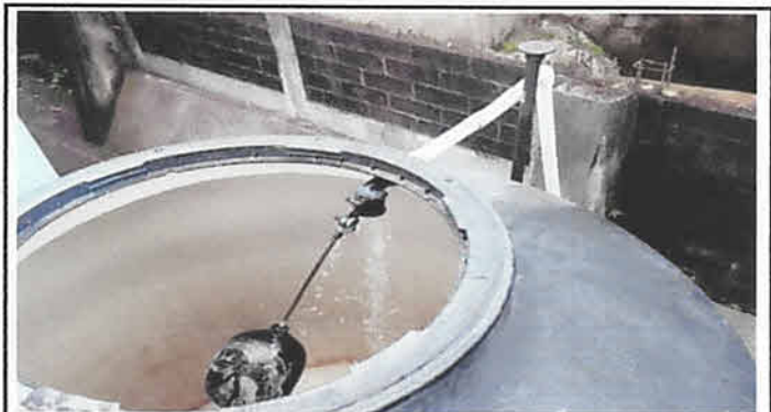
Foto 4:Sustitución de accesorios en baños + sistema hidraulico de depósito de agua
