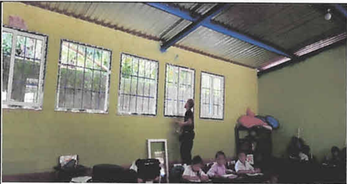
Foto 3: Sustitución de ventanas tipo U-PVC en módulo de primaria 20 mts2
