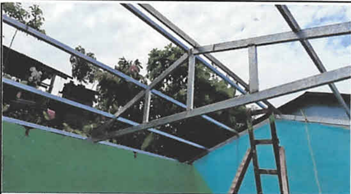
Foto 2: Sustitución de estructura de soporte madera por metal en módulo de primaria 117 mts2
