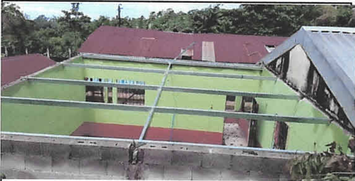
Foto1: Sustitución de lámina por lamina troquelada calibre 26 en módulo de primaria 224 mts2
