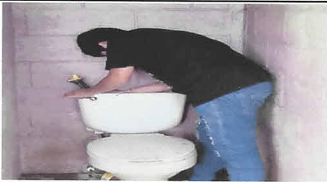
Foto 5: Sustitución de accesorios en baños + sistema hidraulico de depósito de agua
