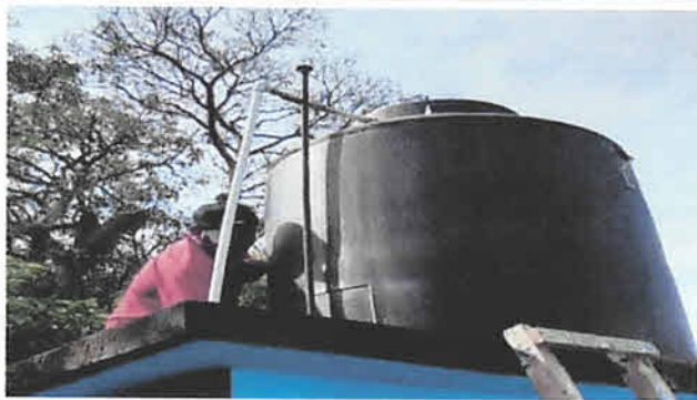
Foto 4: Sustitución de accesorios en baños + sistema hidraulico de depósito de agua
