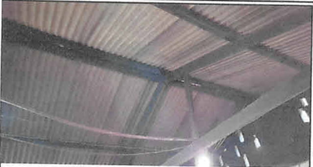
Sustitución de estructura de soporte madera por metal en módulo de primaria 117 mst2
