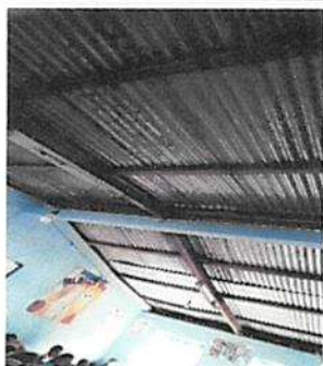
Sustitución de estructura de soporte de madera por metal en los corredores
