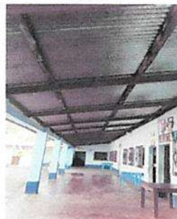
Sustitución de estructura de soporte de madera por metal en los corredores
