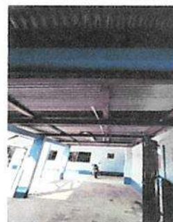
Sustitución de estructura de soporte de madera por metal en los corredores
