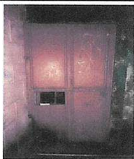
Mantenimiento de portón de la parte de atrás de la escuela
