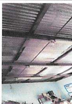
Sustitución de estructura de soporte de madera por metal en los corredores
