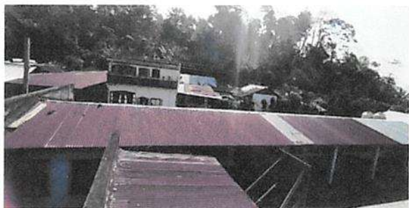
Sustitución de lámina, por lámina troquelada calibre 26
