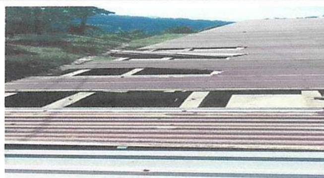
Suministro e Instalación de Estructura de Metal
