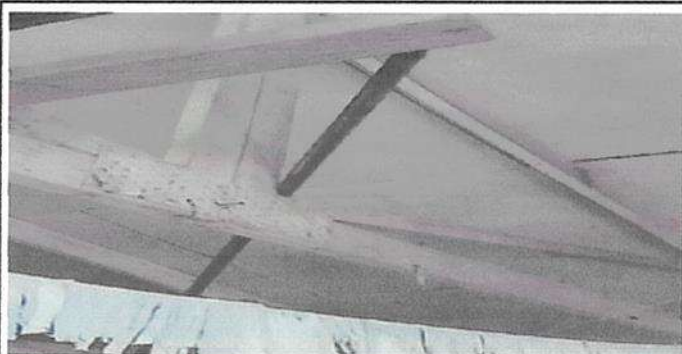
Suministro e Instalación de Estructura de Metal
