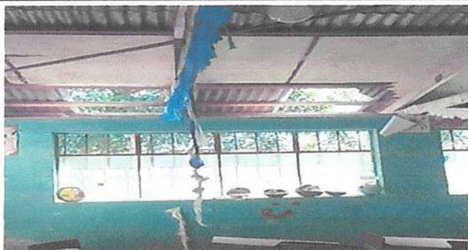
Suministro e Instalación de Estructura de Metal
