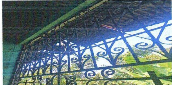
Sustitución de lámina sanitarios, módulo 02
