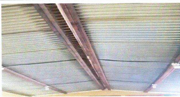
Sustitución de techo en aulas módulo 03
