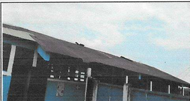
Sustitucion de lamina por lamina troquelada calibre 26 en modulo 1
