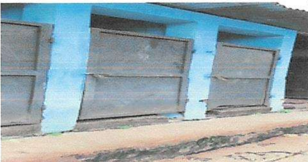
Sustitucion de puerta de servicios sanitarios metalica de 0.20 x 1.20 m
