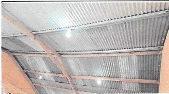
Sustitucion de estructura de soporte madera por metal en modulo 1
