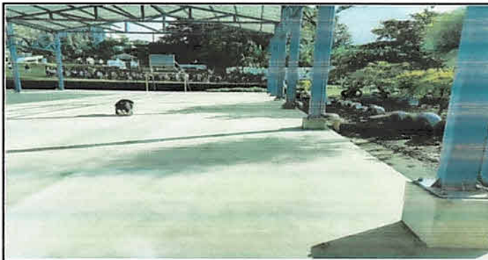
Mantenimiento correctivo de pavimento de cancha.
