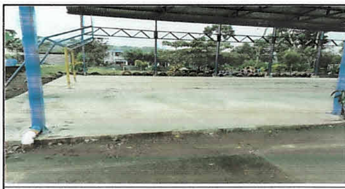
Reemplazo de tubería de pvc de 4" por tubería de pvc de 8"
