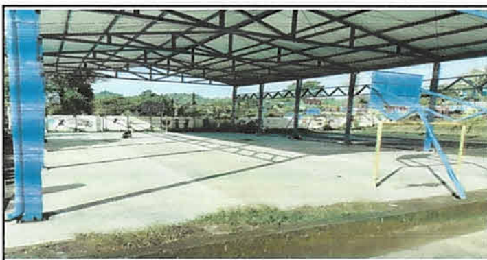
Mantenimiento correctivo de pavimento de cancha
