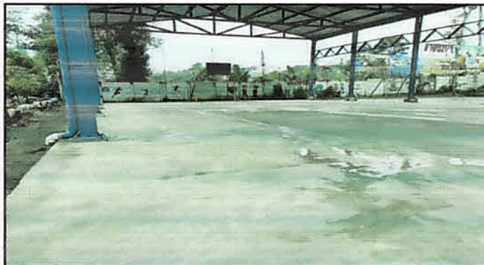
Mantenimiento correctivo de pavimento de cancha
