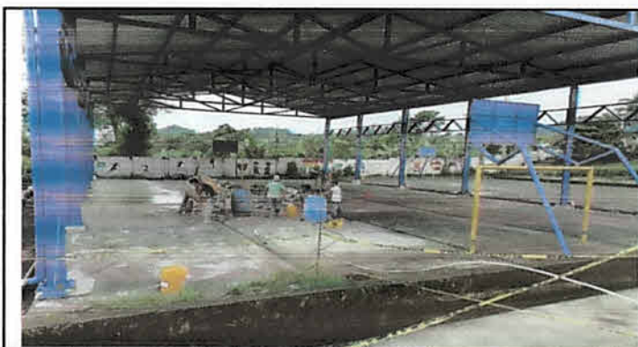
Mantenimiento correctivo de pavimento de cancha
