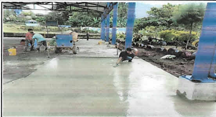
Mantenimiento correctivo de pavimento de cancha.
