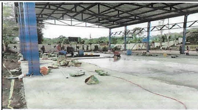
Mantenimiento correctivo de pavimento de cancha
