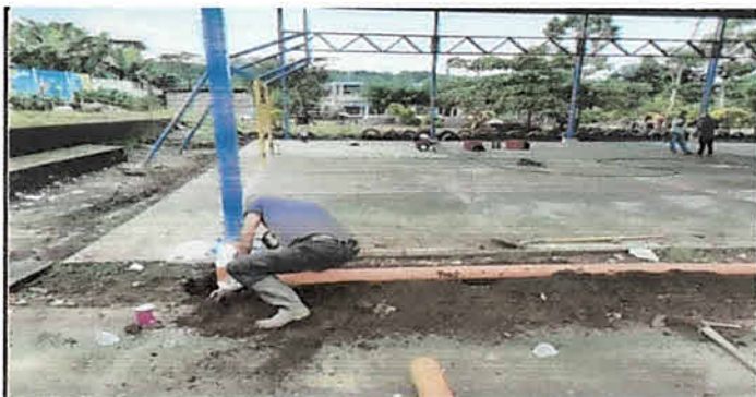
Reemplazo de tubería de pvc de 4" por tubería de pvc de 8"
