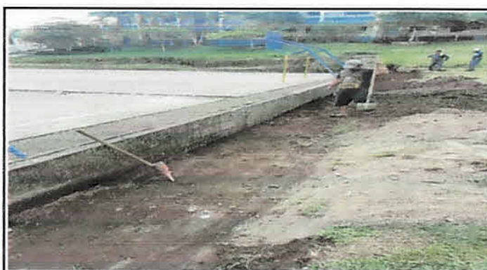
Reparación de manejo de agua pluvial con canal de concreto tipo L.
