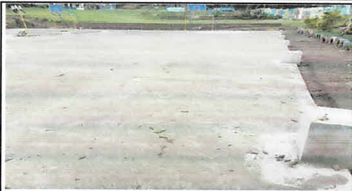
Mantenimiento correctivo de pavimento de cancha.
