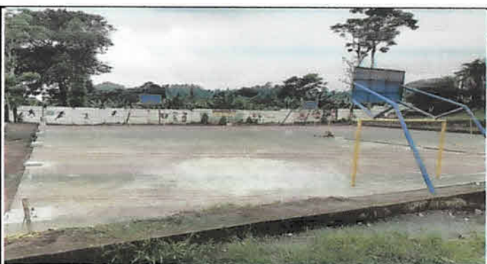
Mantenimiento correctivo de pavimento de cancha
