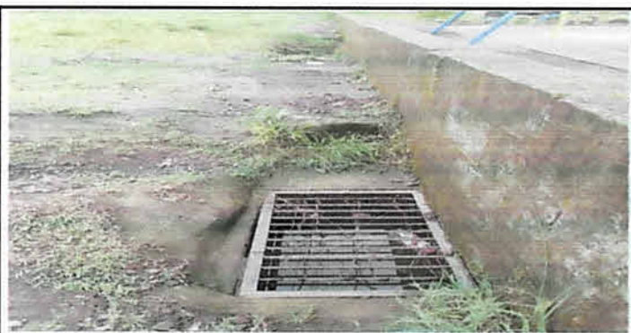
Sustitución de caja de captación de agua pluvial
