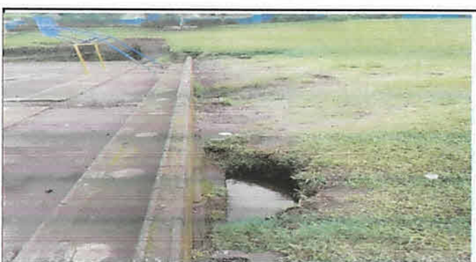
Reparacion de manejo de agua pluvial con canal de concreto tipo L.
