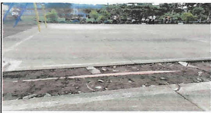
Reemplazo de tubería de pvc de 4" por tubería de pvc de 6"
