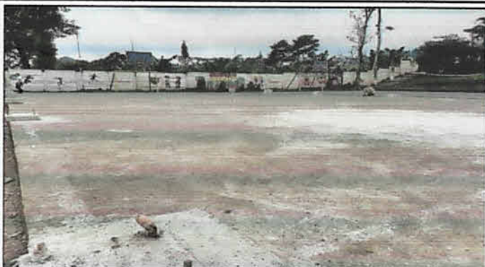
Mantenimiento correctivo de pavimento de cancha
