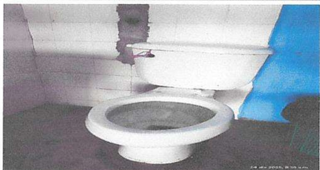
Sustitución de inodoros para baños de docentes
