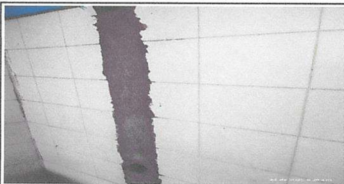
Sustitución de azulejo en baños de docentes
