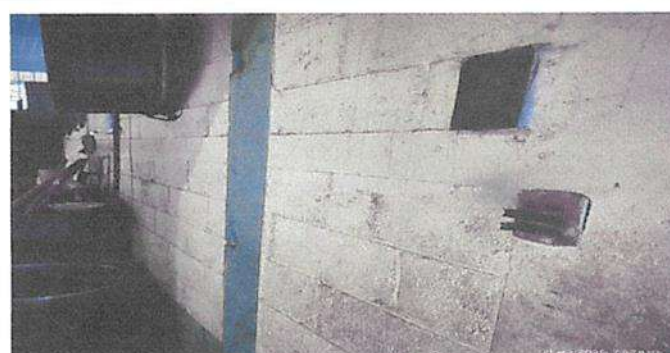
Suministro y aplicación de pintura latex lavable (limpieza, resane y aplicación) para muros de cocina interior
