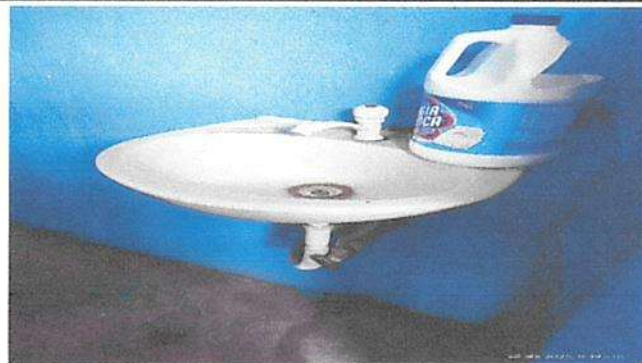
Sustitución de lavamanos en baños de docentes
