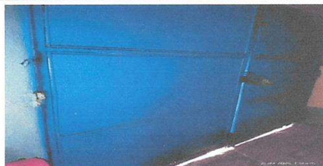
Sustitucion de portón metalico
