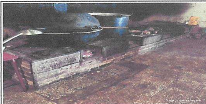
Mantenimiento correctivo de polletón de ladrillo y chimenea
