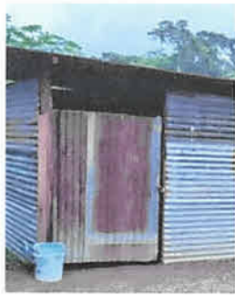
Sustitución de puerta de metal en cocina
