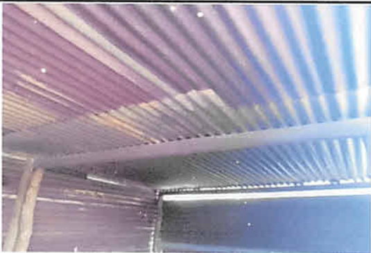
Sustitución de estructura y lámina con costaneras de 2X4 para soporte de techo metálico lamina troquelada galvanizada calibre 26 20mts2, suministro e instalación de sistema eléctrico en cocina (lampara, tomacorriente)
