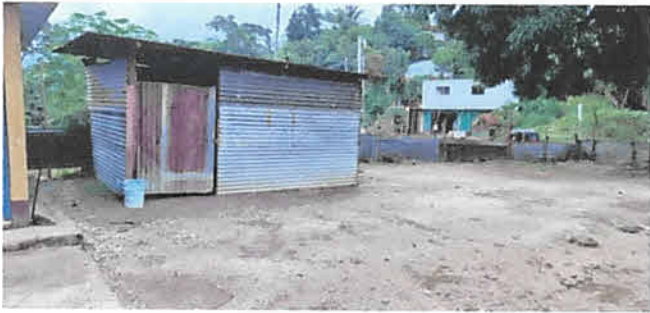
Sustitución de muro prefabricado en cocina 42MTS2.
