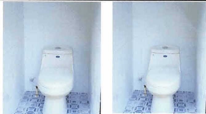
Foto 2: Sustitución de tazas sanitarias.
