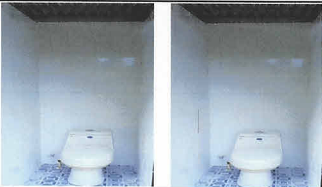
Foto 3: Mantenimiento de muro con azulejos en paredes de servicios sanitarios 40mts2.
