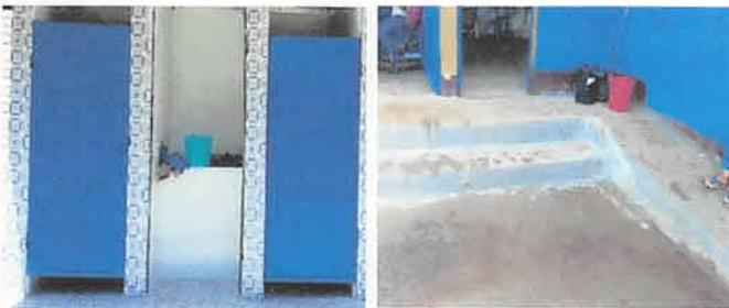
Foto 6: Sustitución de puertas metalicas para servicios sanitarios , sustitución de banquetta existente frente a las aulas 15mts2.
