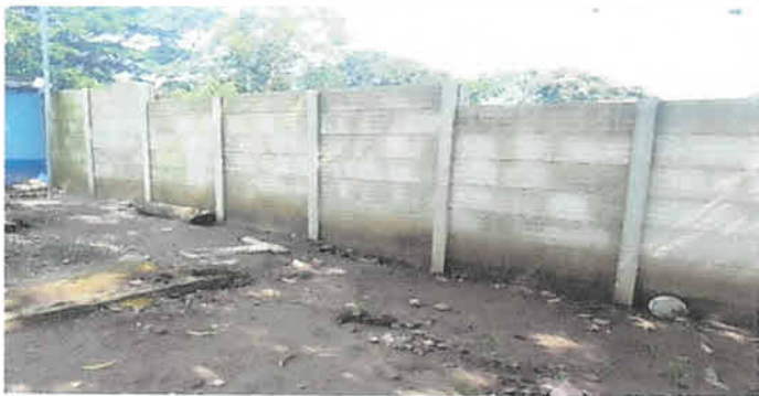
Foto1: Sustitución de muro perimetral con barda prefabricada h=2.50m (concreto reforzado) 75mts2.
