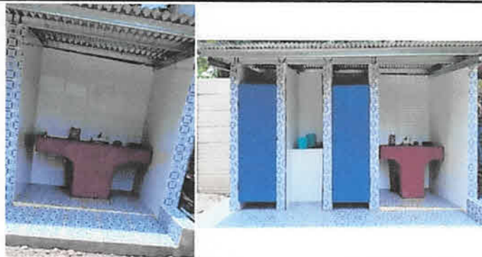
Foto 4: Sustitución de piso antideslizante en servicios sanitarios y pila 10mts2, repellon fino en muro de pila mts2.
