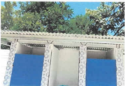
Foto 5: Sustitucion de estructura y lamina , con lamina galvanizada calibre 26 15mts2, Suministro y aplicación en pintura interior y exterior en baños con latex lavable 20mts2.
