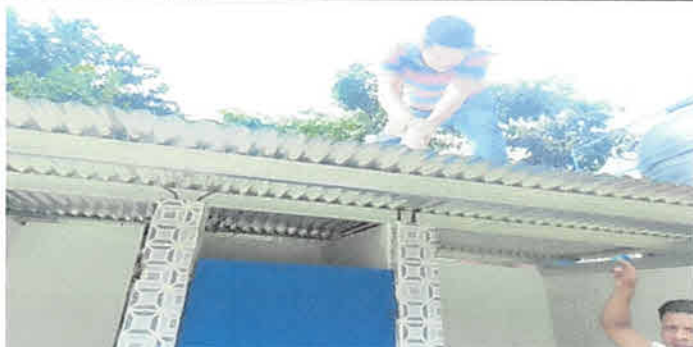
Foto 5: Sustitucion de estructura y lamina , con lamina galvanizada calibre 26 15mts2, Suministro y aplicación en pintura interior y exterior en baños con latex lavable 20mts2.
