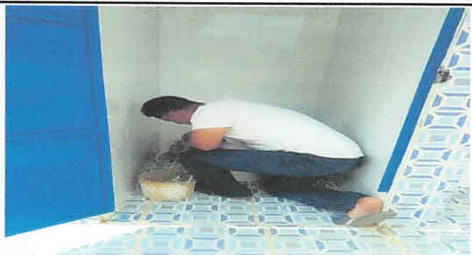
Foto 2: Sustitución de tazas sanitarias.
