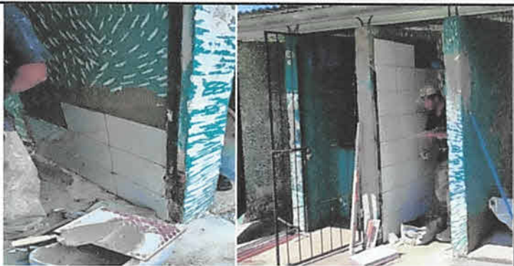
Foto 3: Mantenimiento de muro con azulejos en paredes de servicios sanitarios 40mts2.
