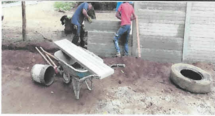
Foto1: Sustitución de muro perimetral con barda prefabricada h=2.50m (concreto reforzado) 75mts2.
