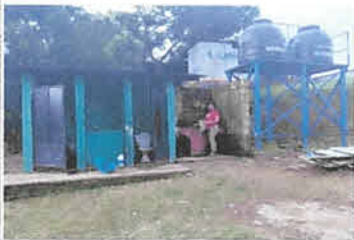
Repello fino en muros de pila 20mts2, instalación de piso antideslizante en servicios sanitarios y pila10mts2.
