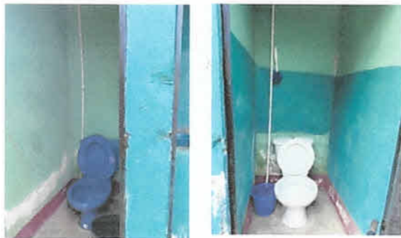
Mantenimiento de muro con azulejo en paredes de servicios sanitarios 40mts2.
