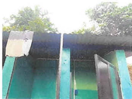
Sustitución de estructura y lámina, con lámina galvanizada calibre 26 15mts2, Suministro y aplicación en pintura interior con latex labable 20mts2
