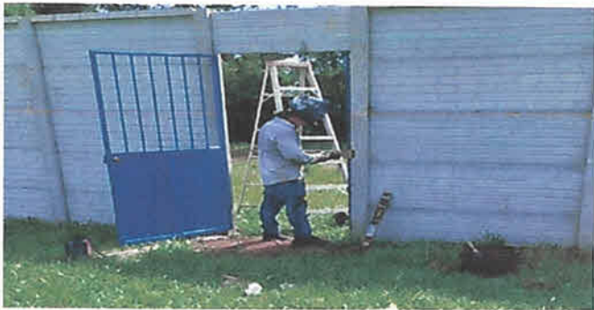
Sustitución de puerta de metal en muro perimetral H=2.10 ancho 1.00 m
