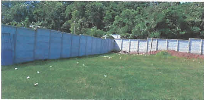
Sustitución de muro perimetral con barda prefabricada de concreto h=2.50m (concreto reforzado) 212 m2
