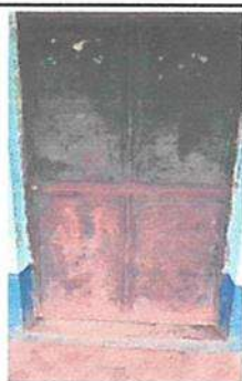
Mantenimiento a estructura, lijado, y aplicación de pintura a puertas metálicas en aulas con mediados de 1.00 * 2.10 mts.
