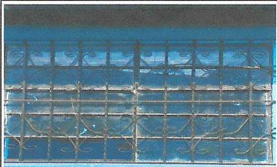
Sustitución de balcones en ventanas de aulas
