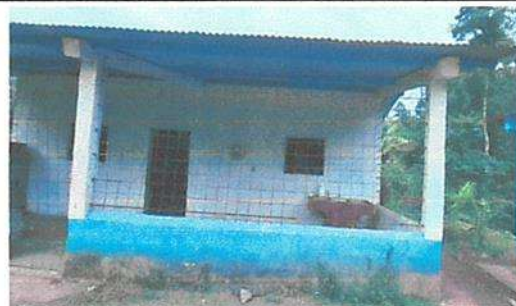
Sustitución de balcones en cocina
