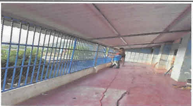
Sustitución de malla por barrotes tipo balcon en corredore de atras (color azul con 17.06 x 1.82 ml con hierro legitimo) 31.05 Mts2
