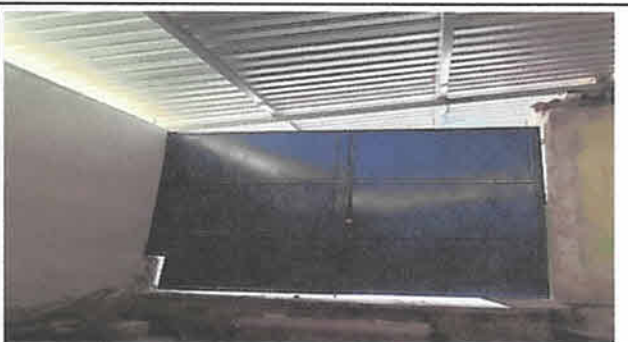
Suministro e Instalacion de porton de metal de doble hoja en el lado de atras (con una dimensión de 2.28 x 2.90 pasadores y chapa yale) 1 Unidad.
