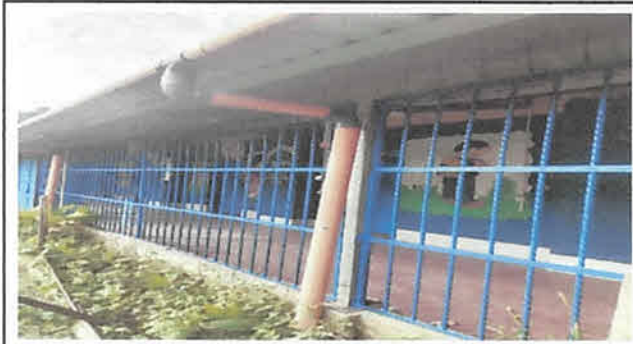
Sustitución de electromalla por barrotes tipo balcon en corredor frontal (Color azul, de 19.60 x 1.80 con hierro legitimo) 35.28 Mts2
