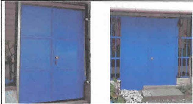
Sustitución de puertas de madera de corredor frontal, por portones de metal doble hoja (con chapa Yale y pintura color azul de 1.50 x 2.20m c/u) 2 Unidad.
