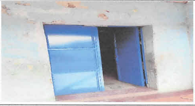
Sustitución de puertas de madera por puertas de metal en la parte de atrás en el grado de SEXTO PRIMARIA (con chapa Marca Yale color azul. De 1.35 x 2.12 mts2). 1 Unidad.
