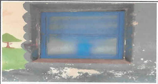
Sustitución de ventanas de madera por ventanas de metal en el lado de enfrente del Grado de SEGUNDO PRIMARIA (con dos pasadores color azul. De 1.50 x 1.05 mts) 1 Unidad.
