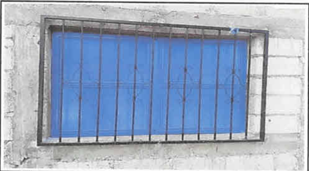
Suministro e Instalación de ventana de madera por ventana de metal doble hoja en el grado de TERCERO PRIMARIA en el lado derecho (con dos pasadores color azul. De 1.50x1.05 mts2) 1 Unidad.
