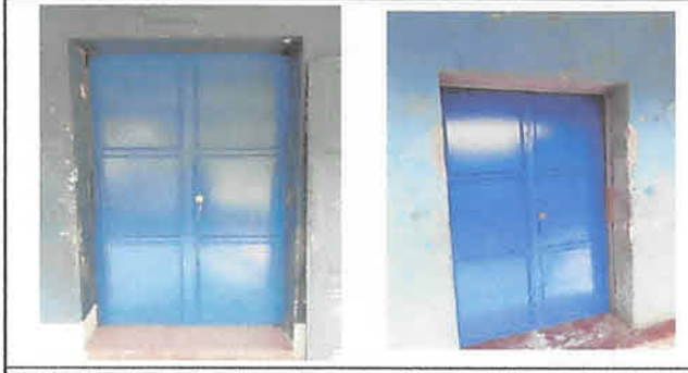
Sustitución de puertas de madera por puertas de metal en ambos lados frente y posterior de SEGUNDO PRIMARIA (con chapa Marca Yale color azul De 1.35 x 2.12 mts) 2 Unidad.
