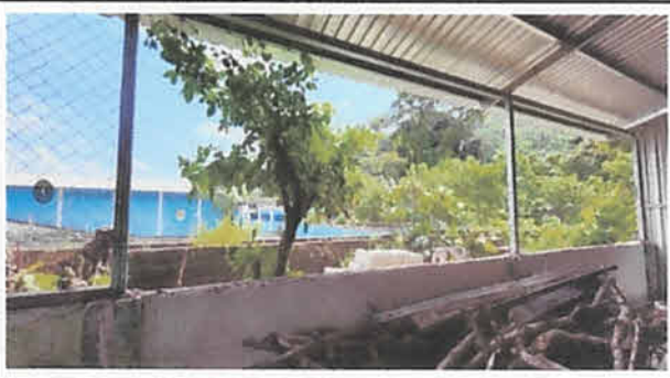
Sustitución de malla por barros tipo balcón en corredore de atras (color azul con 17.06 x 1.82 ml con hierro legítimo) 31.05 Mts2
