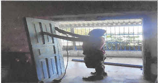
Sustitución de puertas de madera por puertas de metal en la parte de atrás en el grado de SEXTO PRIMARIA (con chapa Marca Yale color azul. De 1.35 x 2.12 mts2). 1 Unidad.
