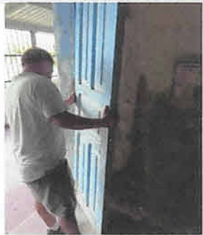
Sustitución de puertas de madera por puertas de metal en ambos lados frente y posterior de SEGUNDO PRIMARIA (con chapa Marca Yale color azul De 1.35 x 2.12 mts) 2 Unidad.
