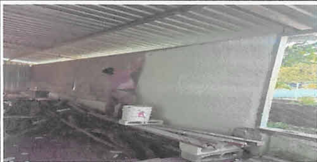
Sustitución de división de malla en corredor por barda prefabricada de concreto DUROCK para un aula, con medida de 8.34 por 1.80 mts2 (incluye repello y pintura color: pantone 293 celeste y zocalo pantone 293 azul) 15.00 Mts2
