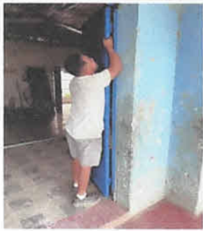
Sustitución de puertas de madera por puertas de metal en ambos lados frente y posterior de SEGUNDO PRIMARIA (con chapa Marca Yale color azul De 1.35 x 2.12 mts) 2 Unidad.
