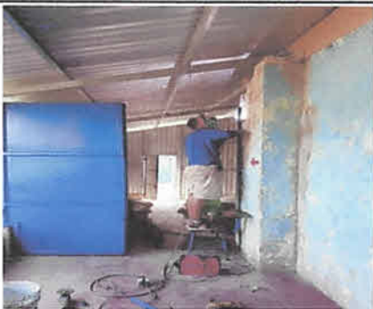
Suministro e Instalacion de porton de metal de doble hoja en el lado de atras (con una dimensión de 2.28 x 2.90 pasadores y chapa yale) 1 Unidad.
