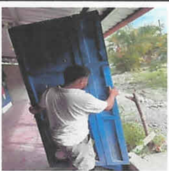
Sustitución de puertas de madera de corredor frontal, por portones de metal doble hoja (con chapa Yale y pintura color azul de 1.50 x 2.20m c/u) 2 Unidad.
