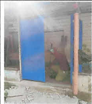
Sustitución de puertas de madera de corredor frontal, por portones de metal doble hoja (con chapa Yale y pintura color azul de 1.50 x 2.20m c/u) 2 Unidad.
