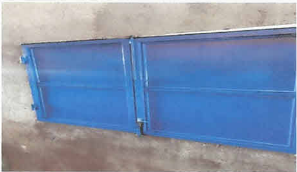
Suministro e instalación de ventana de madera por ventana de metal doble hoja en el grado de TERCERO PRIMARIA en el lado derecho (con dos pasadores color azul. De 1.50x1.05 mts2) 1 Unidad.
