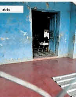
Sustitución de puertas de madera por puertas de metal en ambos lados frente y posterior de SEGUNDO PRIMARIA (con chapa Marca Yale color azul De 1.35 x 2.12 mts) 2 Unidad.
