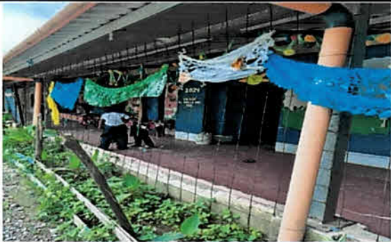
Sustitución de electromalla por barrotes tipo balcon en corredor frontal (Color azul, de 19.60 x 1.80 con hierro legítimo) 35.28 Mts2
