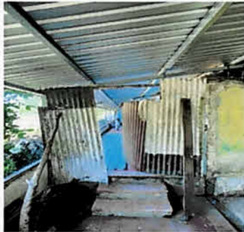
Suministro e Instalacion de porton de metal de doble hoja en el lado de atras (con una dimensión de 2.28 x 2.90 pasadores y chapa yale) 1 Unidad.
