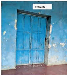
Sustitución de puertas de madera por puertas de metal en ambos lados frente y posterior de SEGUNDO PRIMARIA (con chapa Marca Yale color azul De 1.35 x 2.12 mts) 2 Unidad.
