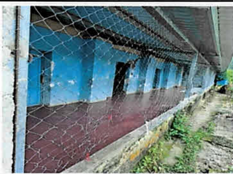
Sustitución de malla por barrotes tipo balcon en corredore de atras (color azul con 17.06 x 1.82 ml con hierro legítimo) 31.05 Mts2
