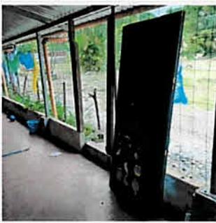
Sustitución de puertas de madera de corredor frontal, por portones de metal doble hoja (con chapa Yale y pintura color azul de 1.50 x 2.20m c/u) 2 Unidad.
