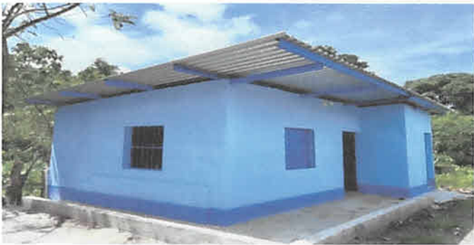
Foto 5: Mejoramiento del muro (reforzamiento columna de puerta y el dintel) cocina
