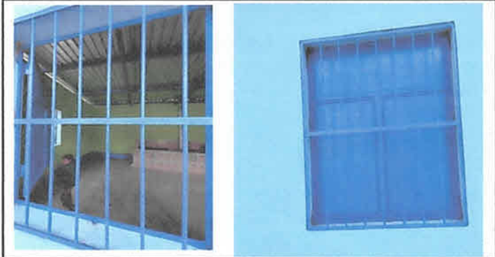
Foto9: Suministro e instalación de ventana de metal
