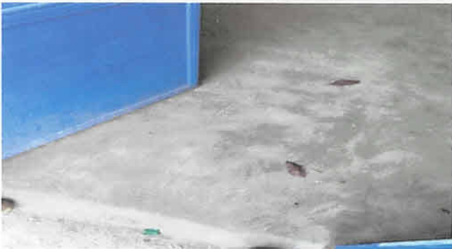
Foto 3: Sustitución de piso de cemento líquido 42 mts2.
