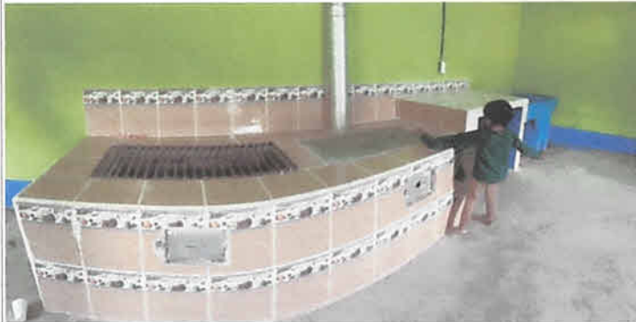
Foto7:Sustitución de estufa rural (incluye chimenea de acero inoxidable AISI 316L, de 100 mm de diámetro y 1 plancha de metal de 3 hornillas y 1/4 de espesor)
