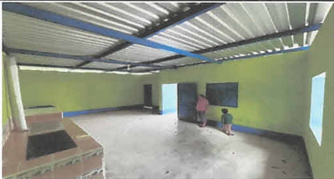
Foto 6: Repello de muro
