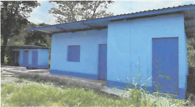
Foto 8: Aplicación de pintura látex acrílico de primera calidad (antihongos), en muros (interiores y exteriores) de cocina y baño 34.80 mts 2.
