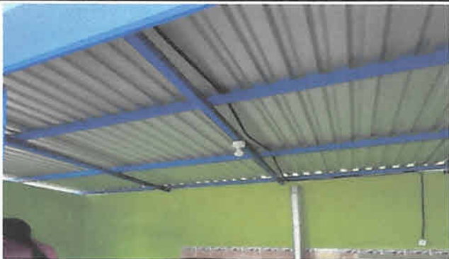
Foto 2: Sustitución de estructura de soporte de madera, por metal en cocina 45 mts2.
