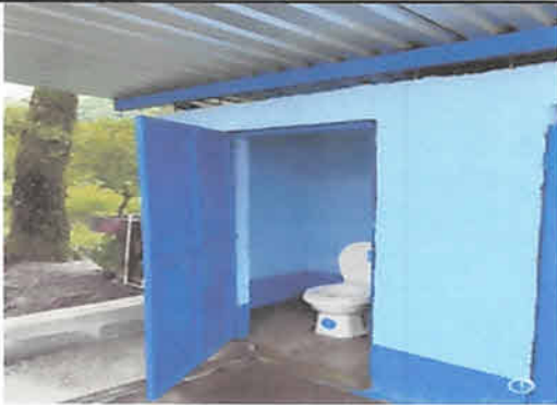
Foto 4: Sustitución de puertas (incluye chapas de primera calidad) en cocina y sanitario.
