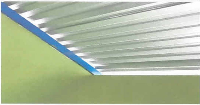
Foto1: Sustitución de lámina por lámina troquelada aluzinc- calibre 26 (incluye tornillos) en cocina 45 mts 2.
