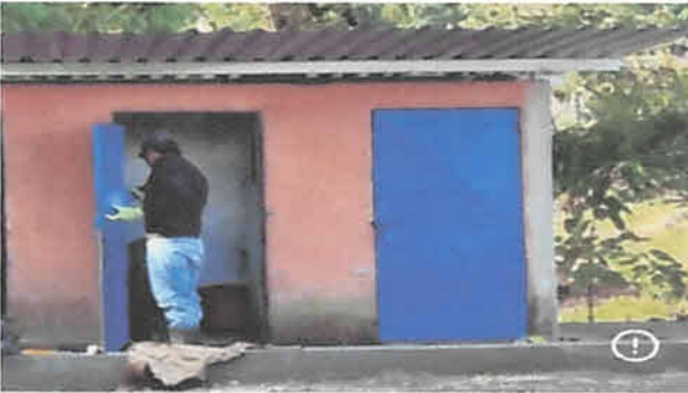
Foto 4:Sustitución de puertas (incluye chapas de primera calidad) en cocina y sanitario.
