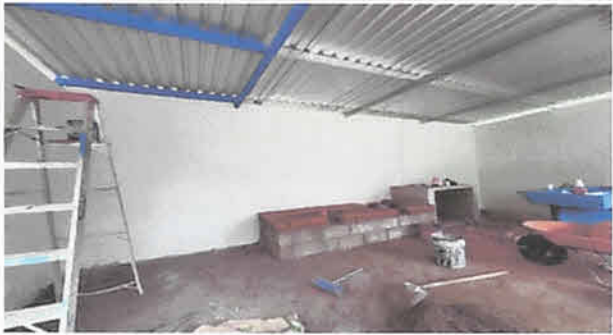
Foto 6: Repello de muro
