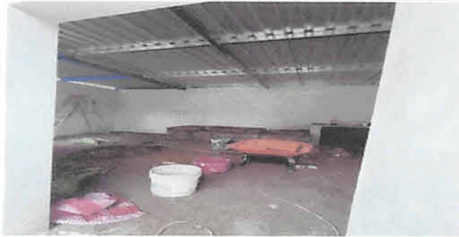
Foto9: Suministro e instalación de ventana de metal
