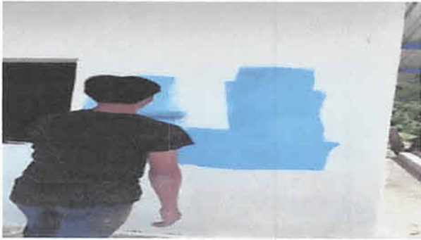
Foto 8: Aplicación de pintura látex acrílico de primera calidad (antihongos), en muros (interiores y exteriores) de cocina y baño 34.80 mts 2.
