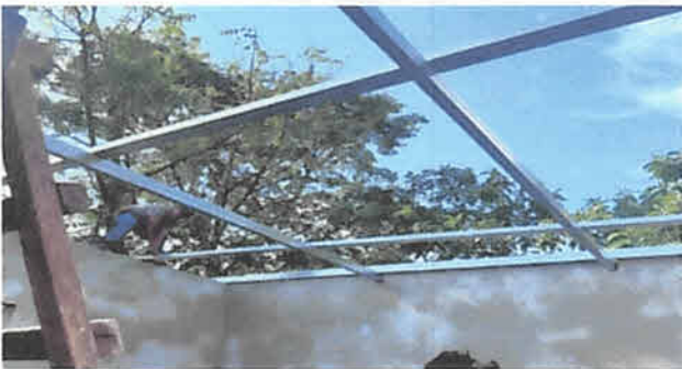
Foto 2: Sustitución de estructura de soporte de madera, por metal en cocina 45 mts2.
