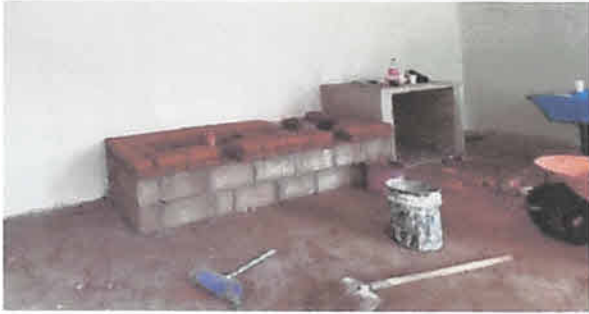
Foto7:Sustitución de estufa rural (incluye chimenea de acero inoxidable AISI 316L, de 100 mm de diámetro y 1 plancha de metal de 3 hornillas y 1/4 de espesor)
