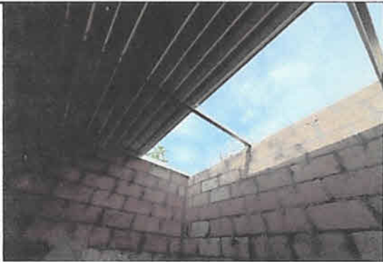
Foto1: Sustitución de lámina por lámina troquelada aluzinc- calibre 26 (incluye tornillos) en cocina 45 mts2.
