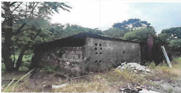
Foto. No 5. Mejoramiento del muro en cocina
