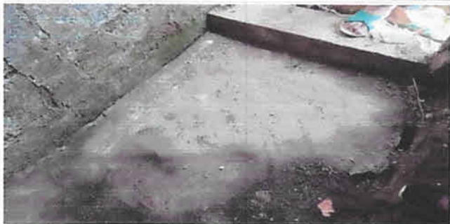
Foto. No 3. Sustitución de piso de cemento líquido 42 mts 2.
