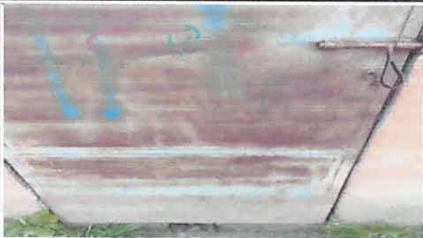
Foto. No 4. Sustitución de puertas (incluyen chapas de primera calidad) en cocina y sanitarios.
