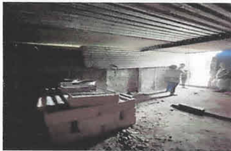
Foto. No 6. Repello de muro.
