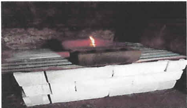
Foto. No 7. Sustitución de estufa rural (incluye chimenea de acero inoxidable AISI 316L, de 100 mm de diámetro y 1 plancha de metal de 3 hornillas y 1/4 de espesor)
