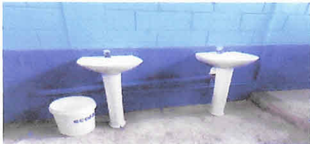
11, Sustitución lavamanos con grifería, 4 unidades.
