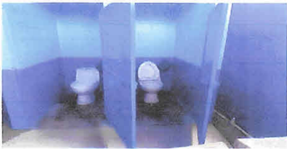
10, Sustitución de inodoro elongado, 6 unidades.
