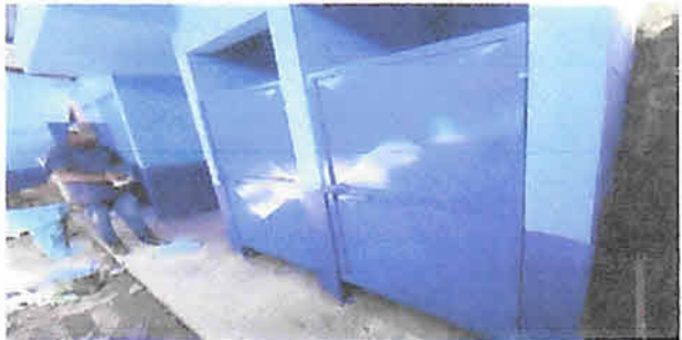
4, Sustitución de puerta de servicios sanitarios metálica, 6 unidades.
