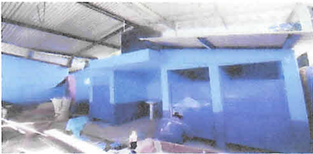
3, Sustitución de puerta de servicios sanitarios metálica, 6 unidades.
