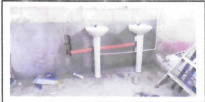
11, Sustitución lavamanos con grifería, 4 unidades.
