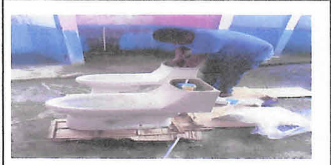
9, Sustitución de inodoro elongado, 6 unidades.
