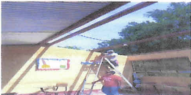
2, Sustitución de lámina, por lámina troquelada calibre 26 en módulo, 180 m2.
