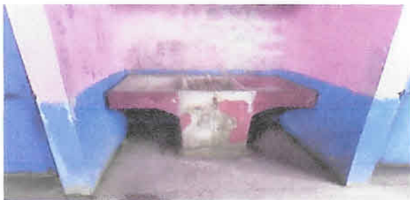
Foto 5: Sustitución lavamanos con grifería. 4 unidades.
