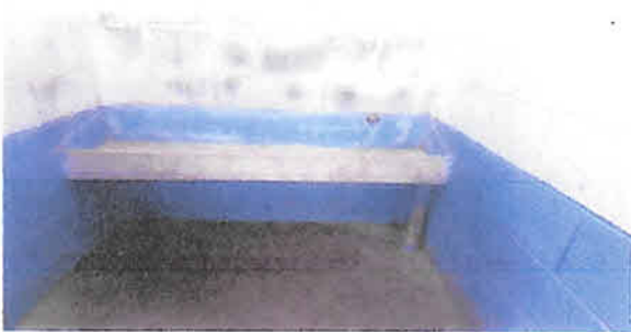
Foto 2: Sustitución de Mingitorio. 2 unidades.
