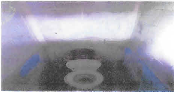
Foto 3: Sustitución Inodoro elongado. 6 unidades.
