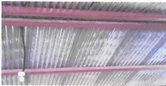
Foto 8: Sustitución de lámina, por lámina troquelada calibre 26" en módulo. 180 m2.
