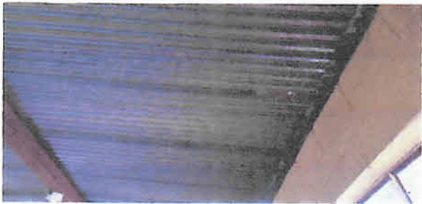
Foto 7: Sustitución de lámina, por lámina troquelada calibre 26" en módulo. 180 m2.
