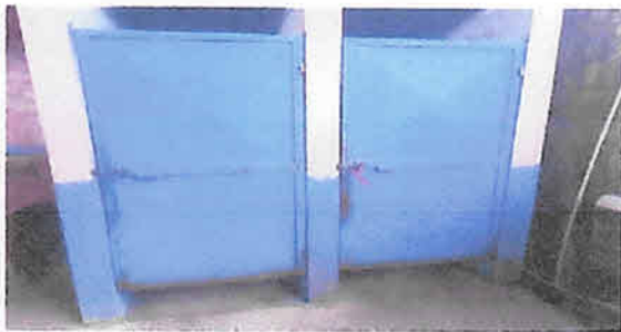
Foto 10: Sustitución de puerta de servicios sanitarios metálica, 6 unidades.
