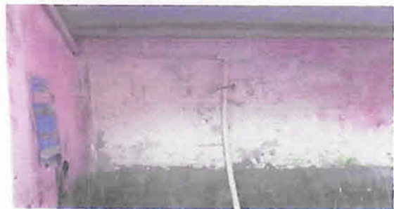
Foto 12: Suministro y aplicación de pintura interior latex lavable celeste pantone 293 y zocalo azul pantone 293. 180 m2.
