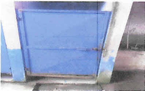
Foto 9: Sustitución de puerta de servicios sanitarios metálica, 6 unidades.
