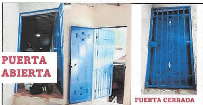
Foto 3: Suministro e instalación de puerta metálica, módulo 3, segundo piso
