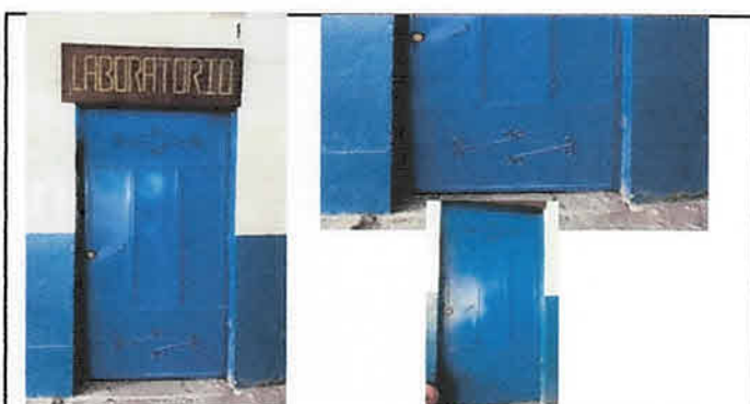
Foto 4: Sustitución de puerta metal aula laboratorio, módulo I, piso 1.
