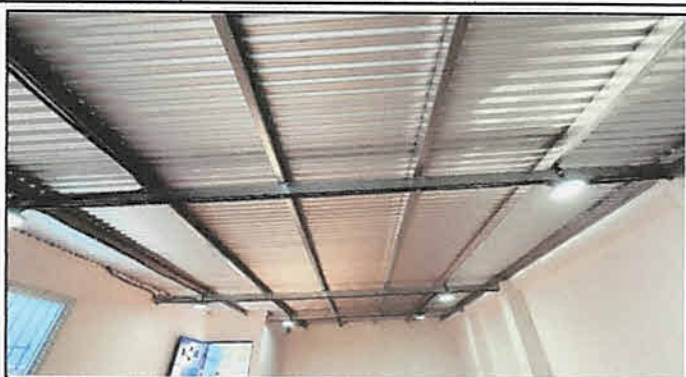
Foto 2: Suministro e instalación estructura metálica, módulo 3, segundo piso
