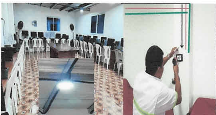
Foto 10: Mantenimiento correctivo suministro e instalación de cableado eléctrico, módulo 3, segundo piso
