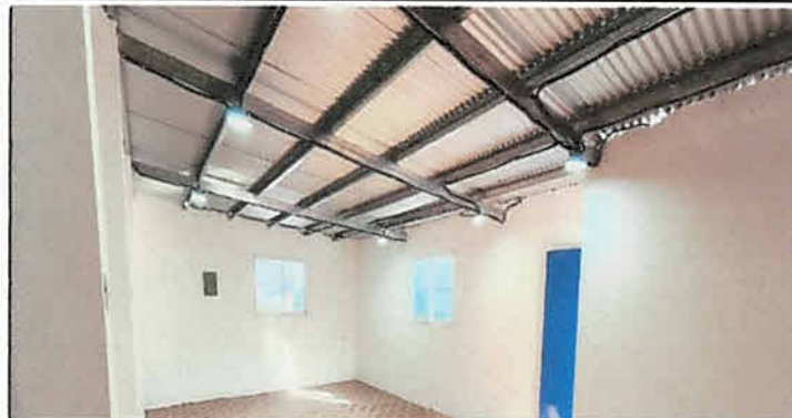
Foto 1: Suministro e instalación de techo de lámina acanalada calibre 26 G, módulo 3, piso 2
