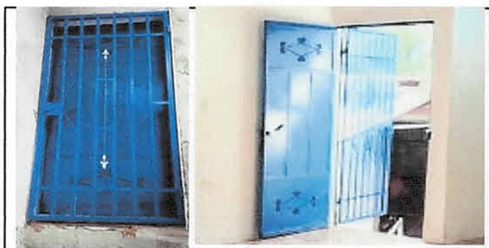
Foto 5: Suministro e instalación de reja metálica de seguridad para puerta, módulo 3, piso 2
