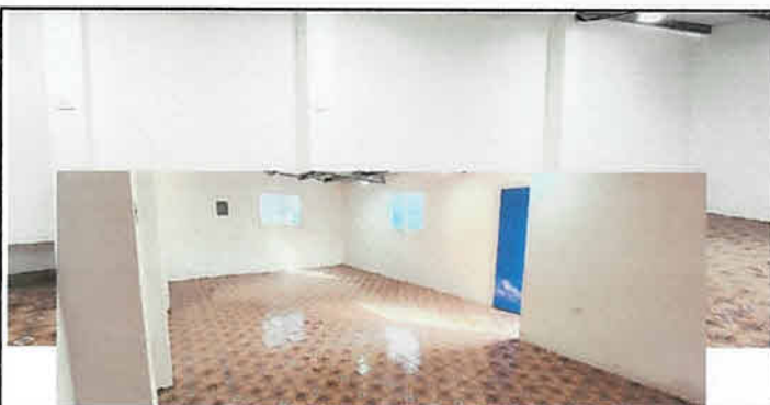
Foto 9: Mantenimiento correctivo a paredes con repello, módulo 3, segundo piso
