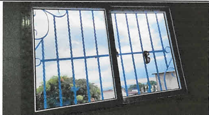
Foto 7: Suministro e instalación de ventanas PVC, módulo 3, segundo piso
