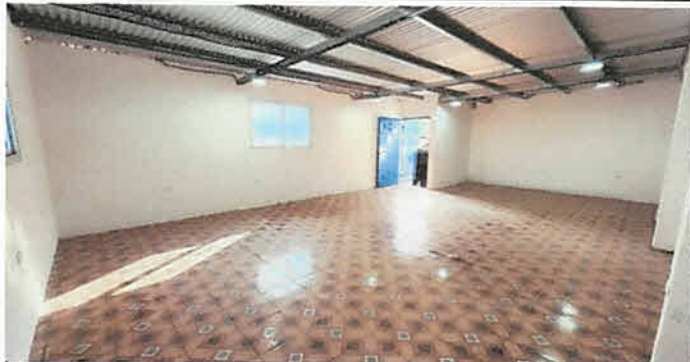
Foto 8: Mantenimiento correctivo sustitución de piso de torta de cemento por cerámica, módulo 3, piso 2
