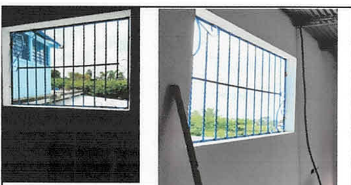
Foto 6: Suministro e instalación de balcones de metal en ventanas, módulo 3, segundo piso
