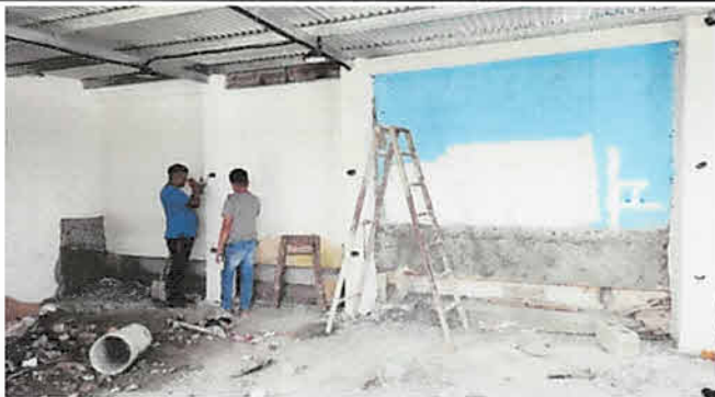
Foto 9: Mantenimiento correctivo a paredes con repello, módulo 3, segundo piso
