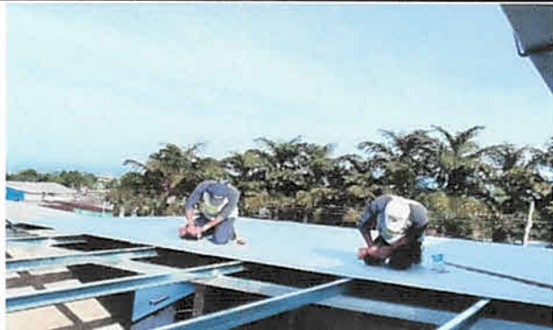
Foto 1: Suministro e instalación de techo de lámina acanalada calibre 26 G, módulo 3, piso 2
