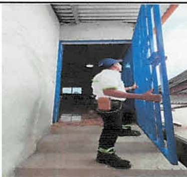
Foto 5: Suministro e instalación de reja metálica de seguridad para puerta, módulo 3, piso 2
