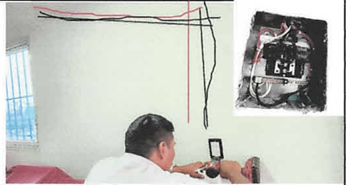
Foto 10: Mantenimiento correctivo suministro e instalación de cableado eléctrico, módulo 3, segundo piso
