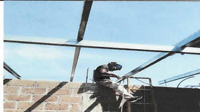
Foto 2: Suministro e instalación estructura metálica, módulo 3, segundo piso
