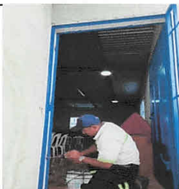
Foto 3: Suministro e instalación de puerta metálica, módulo 3, segundo piso
