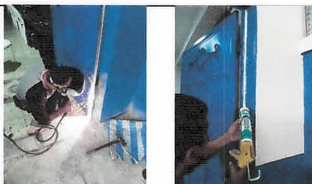
Foto 4: Sustitución de puerta metal aula laboratorio, módulo I, piso 1.
