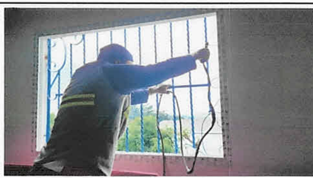
Foto 6: Suministro e instalación de balcones de metal en ventanas, módulo 3, segundo piso
