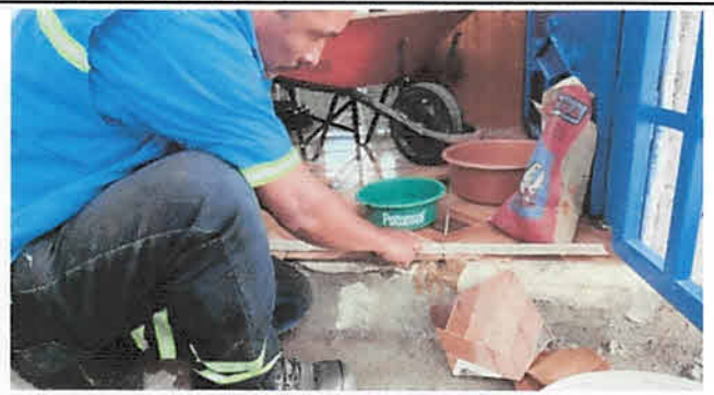
Foto 8: Mantenimiento correctivo sustitución de piso de torta de cemento por cerámica, módulo 3, piso 2
